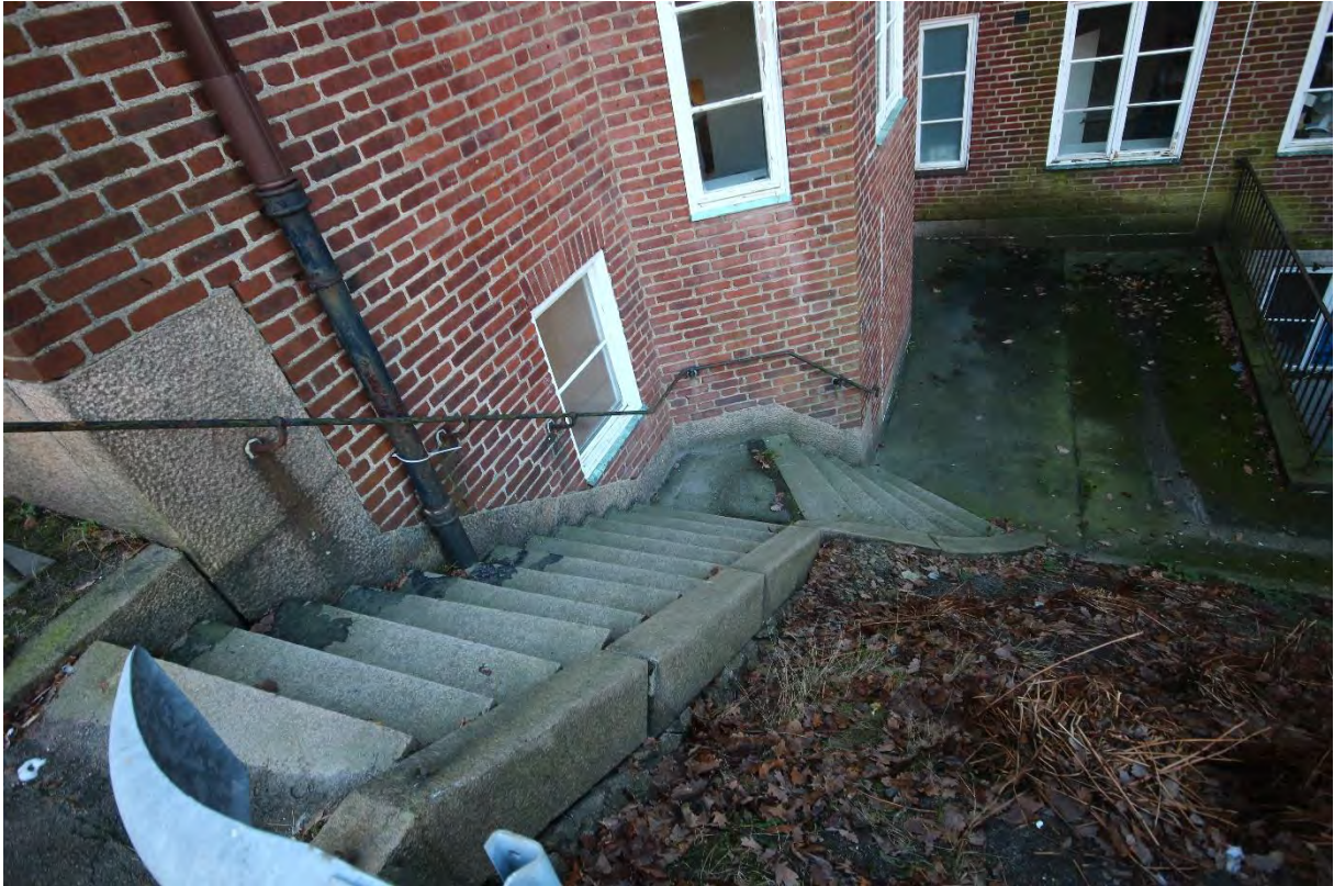
Stentrappa till gården med handledare i smide infäst i fasaden.
