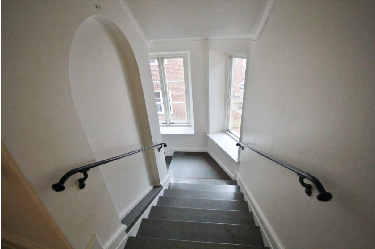
Trapphuset, vy mot gården. Samtliga delar i bild är original.
