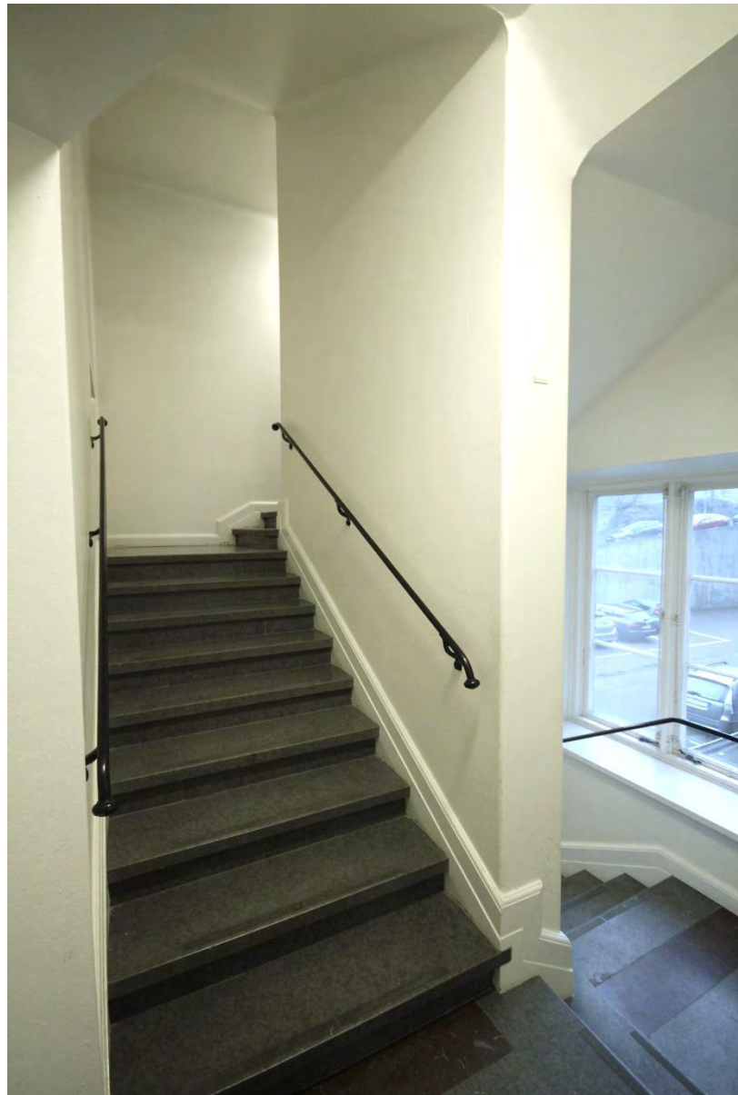
Trappa i grå kalksten, handledare i smidesjärn, putsade väggar och tak. Samtliga delar är original.
