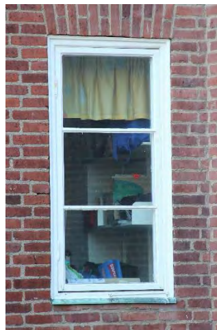
Exempel på originalfönster i olika utförande. Två- respektive enluftsfönster med liggande spröjs samt korspostfönster med liggande spröjs i nedre bågarna. Fönsterbleck i kopparplåt – original.
