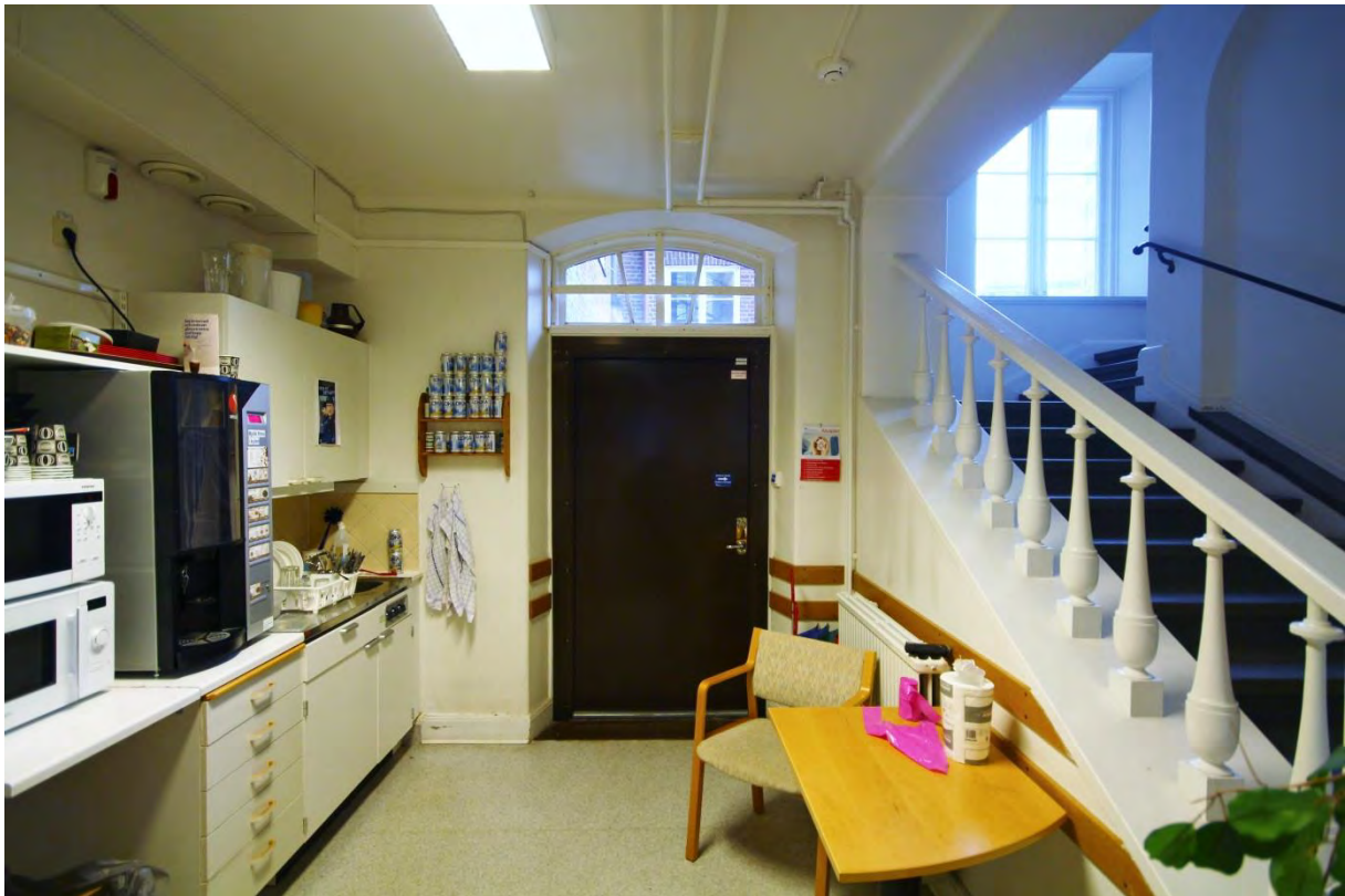
Rum 02.237. Dörr mot gården är utbytt. Överljuset är original, liksom sockeln mot yttervägg och trapppröcket till höger i bild.
