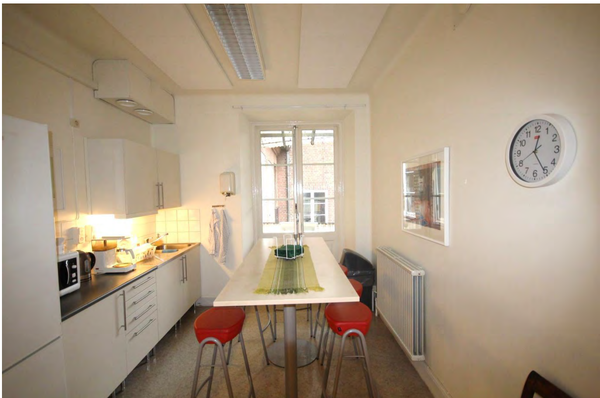
Rum 05.532. Rummet har bevarade detaljer i form av sockel, fönsterdörr och putsat tak med taklist.
