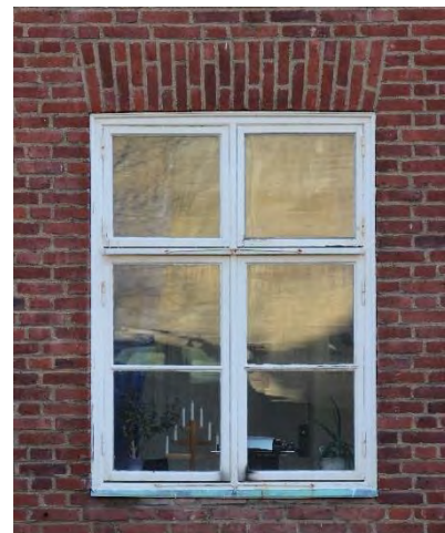
Exempel på originalfönster i olika utförande. Två- respektive enluftsfönster med liggande spröjs samt korspostfönster med liggande spröjs i nedre bågarna. Fönsterbleck i kopparplåt – original.
