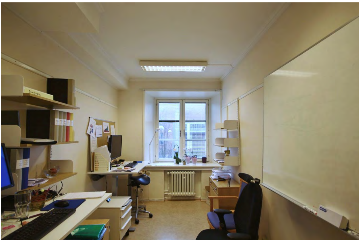
Rum 01.123-25. Rumsindelningen är från 1965, men balken i taket till vänster i bild är original. Planlösningen var utformad med stora rum som kunde delas av till mindre rum med lättväggar.
