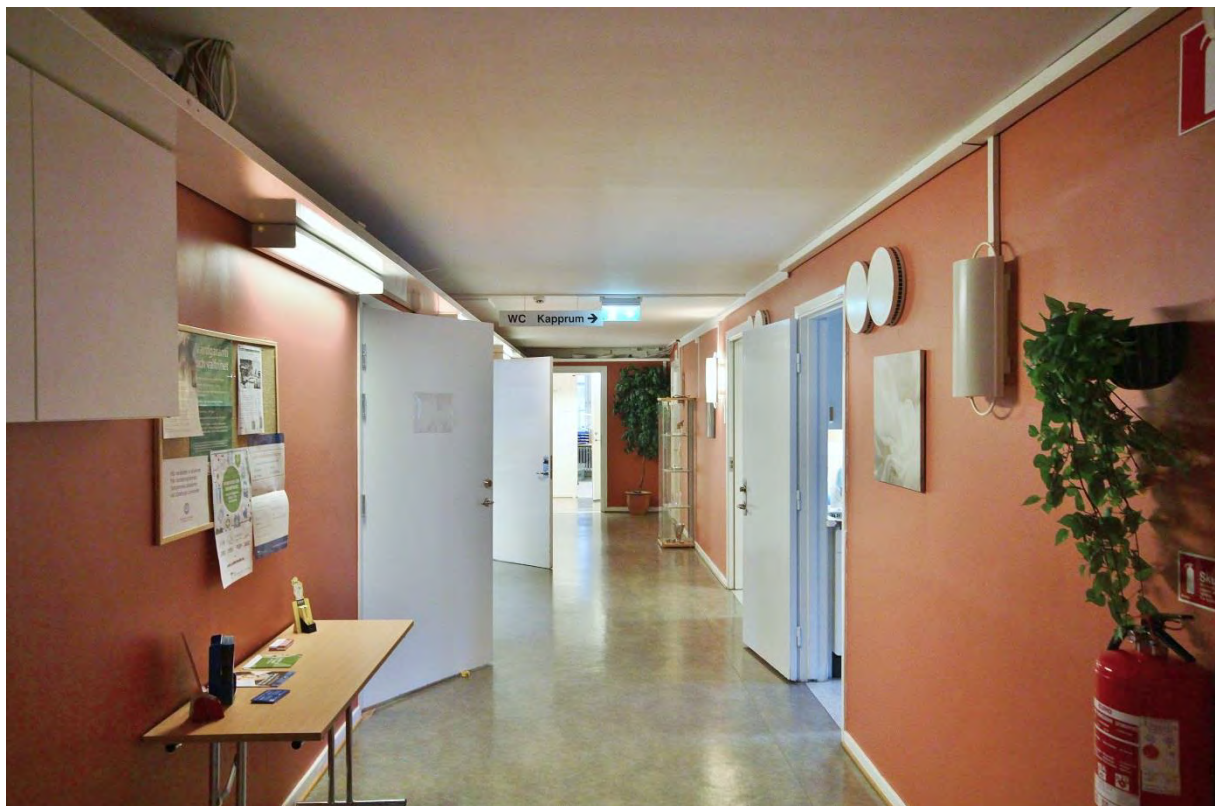
Rum 02.202. Korridoren utgör en del av ursprunglig planlösning men har inga bevarade originaldetaljer.
