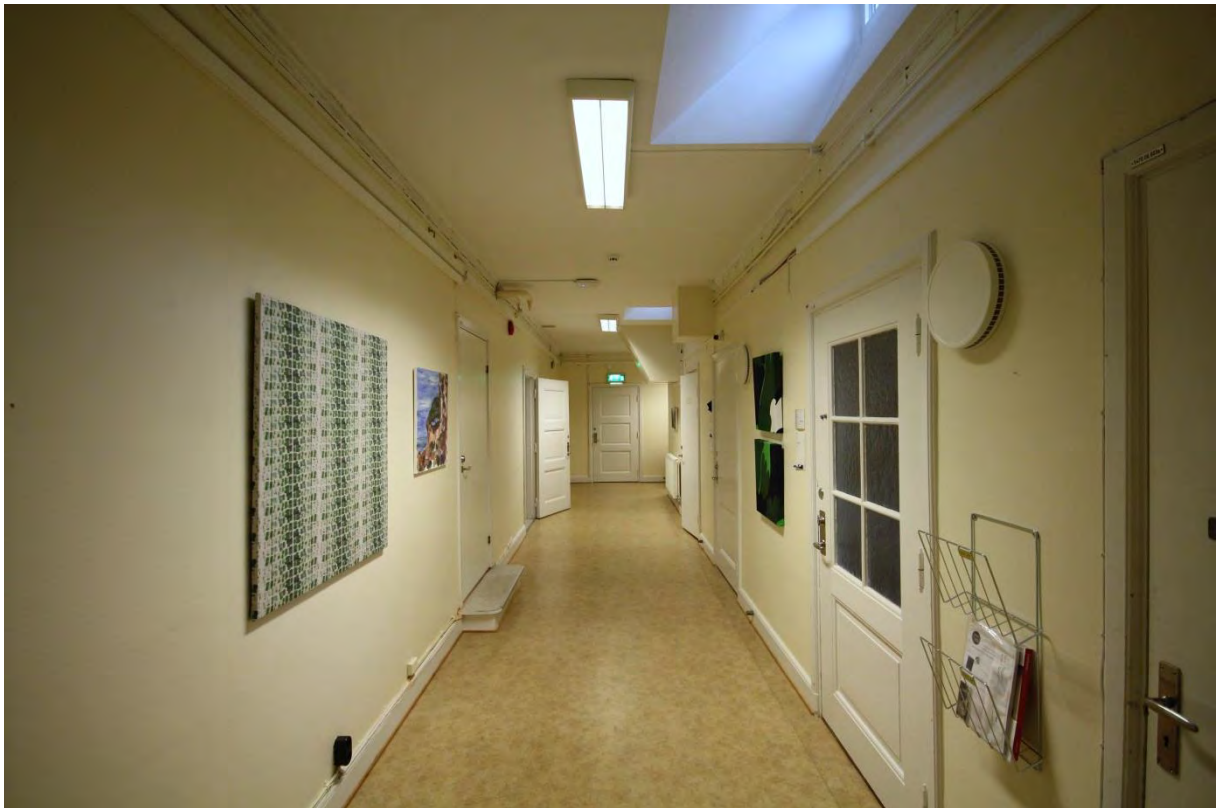
Rum 06.601. Korridor med i huvudsak ursprunglig rumsindelning och originalinslag i form av socklar, foder, dörrar, putsade väggar, tak och takfönster.
