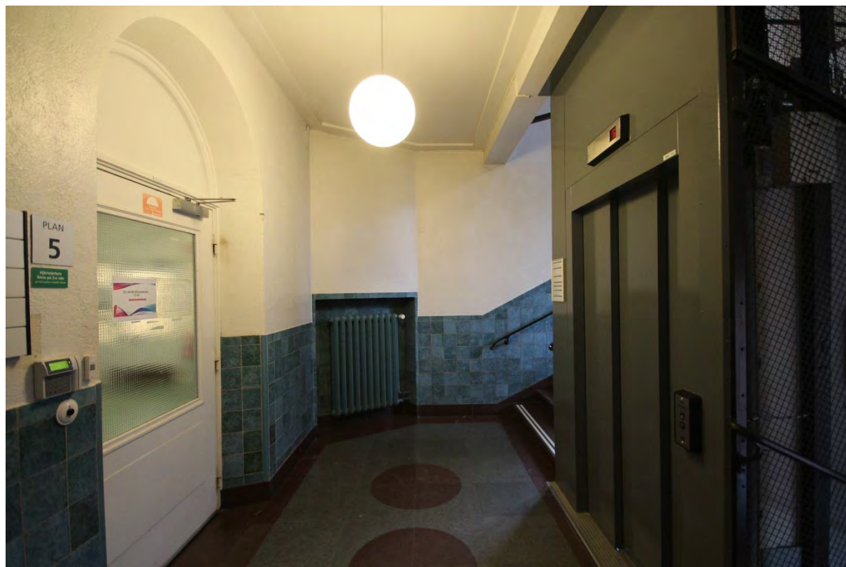
Rum 05.500. Vilplan med ursprunglig rumsindelning. Originalmaterial av hög kvalitet – golv i röd och grå kalksten och kakelbröstning. Plan 5 har ett annorlunda mönster i kalkstengolvet än de nedre planen.
