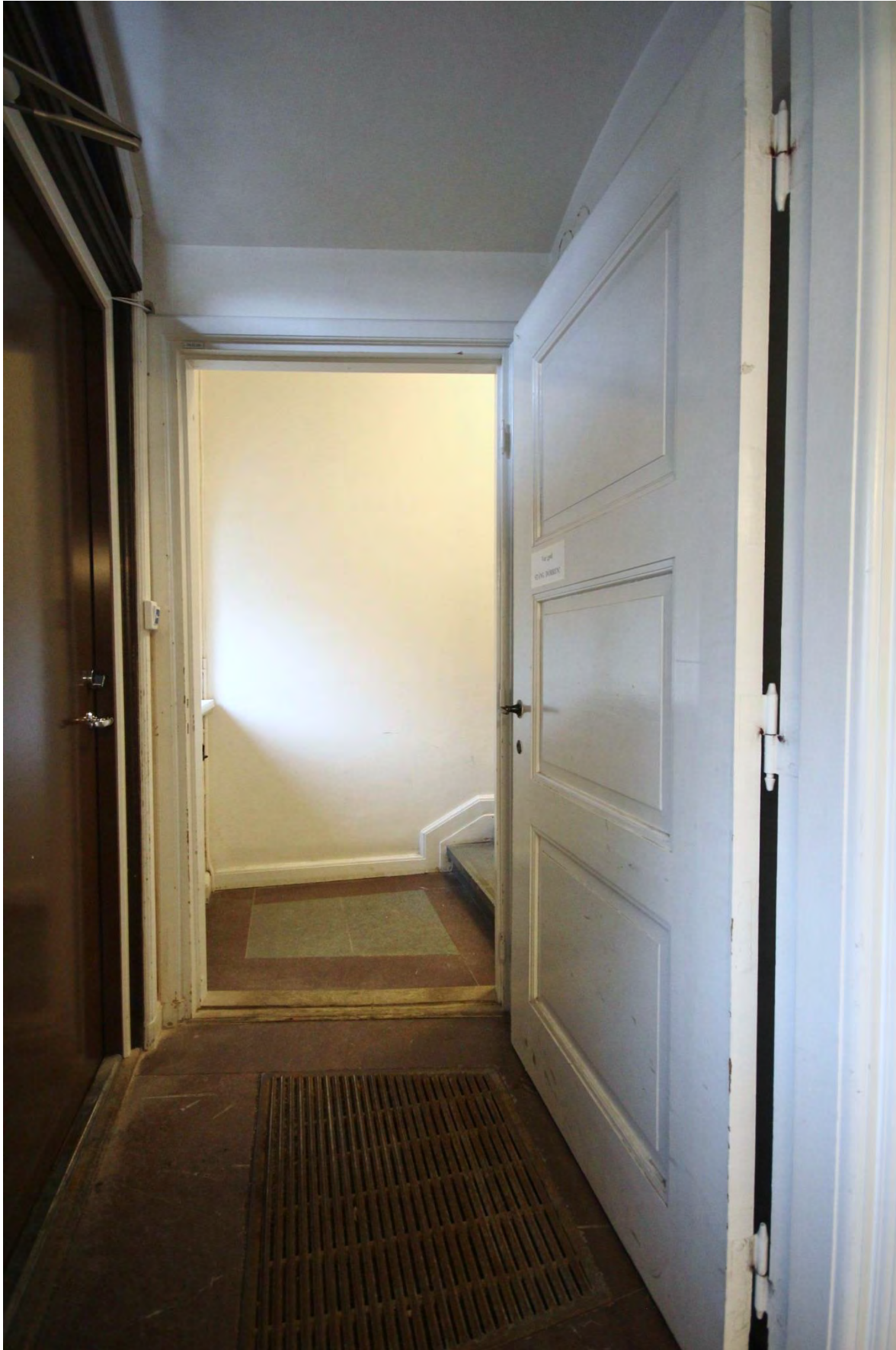
Vindfång vid entré mot gården. Golv i röd kalksten med infälld skoskrapa och spegeldörr. Samtliga delar i bild är original utom ytterdörren.
