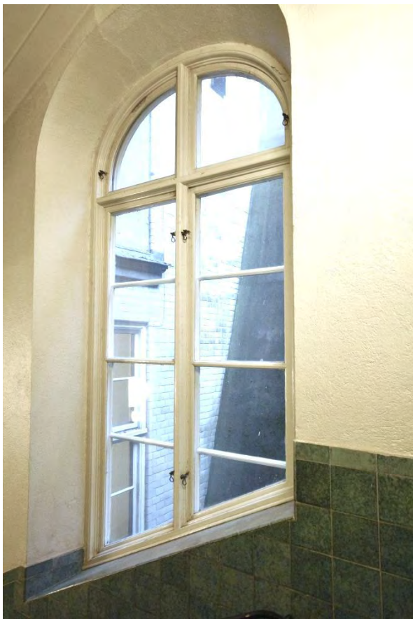
Välvda, spröjsade korspostfönster sitter i varje yttervägg, åt tre väderstreck, och förser trapphuset med dagsljus. Fönstren är original.
