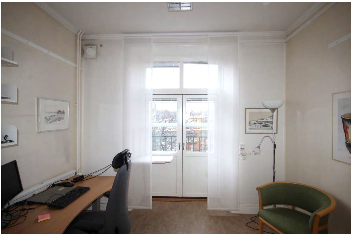
Rum 05.525. Rummet var ursprungligen en del av korridoren och fungerade som dagrum. Det finns bevarade originaldetaljer i form av socklar, foder, dörr, taklist och tak.
