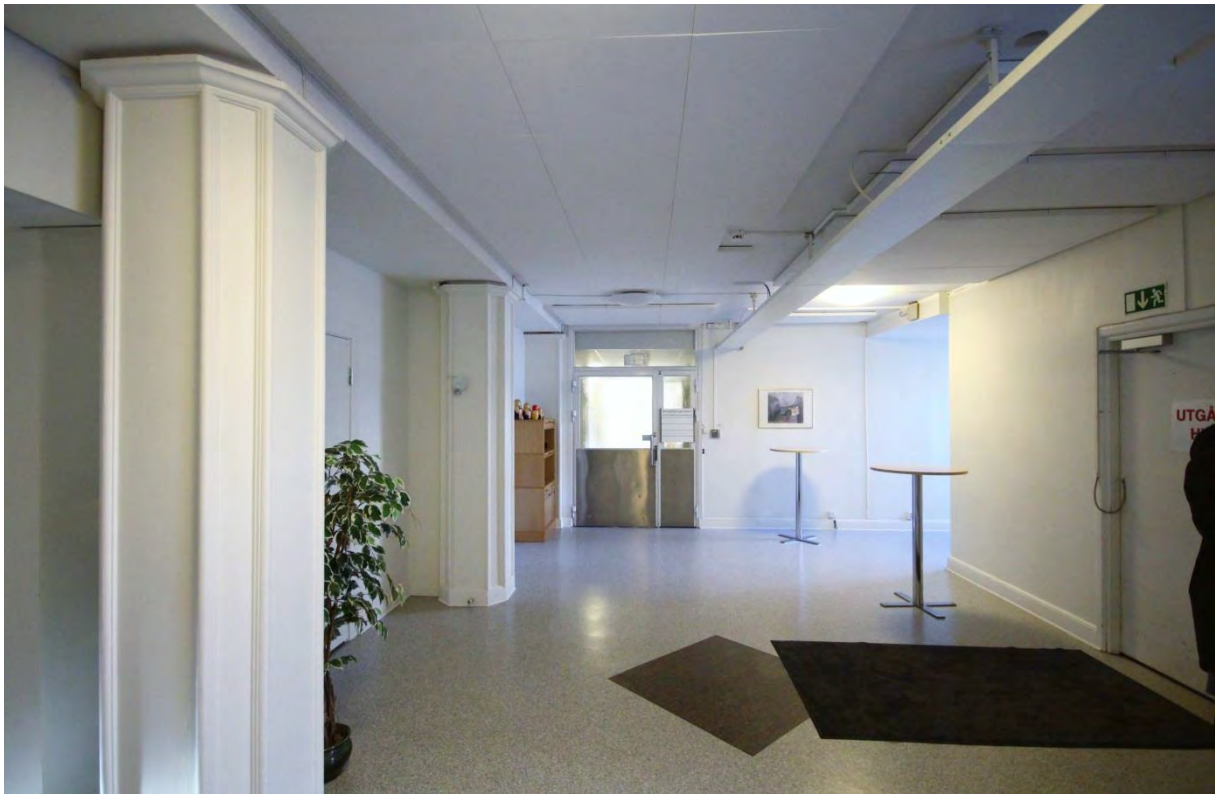
Rum 03.301. Entréhall, ursprungligen väntrum, med originalinslag i form av putsade väggar, pelare och fönsterdörrar mot gården. Till vänster i bild skymtar senare tillkommen vägg som förminskat det ursprungliga väntrummet.
