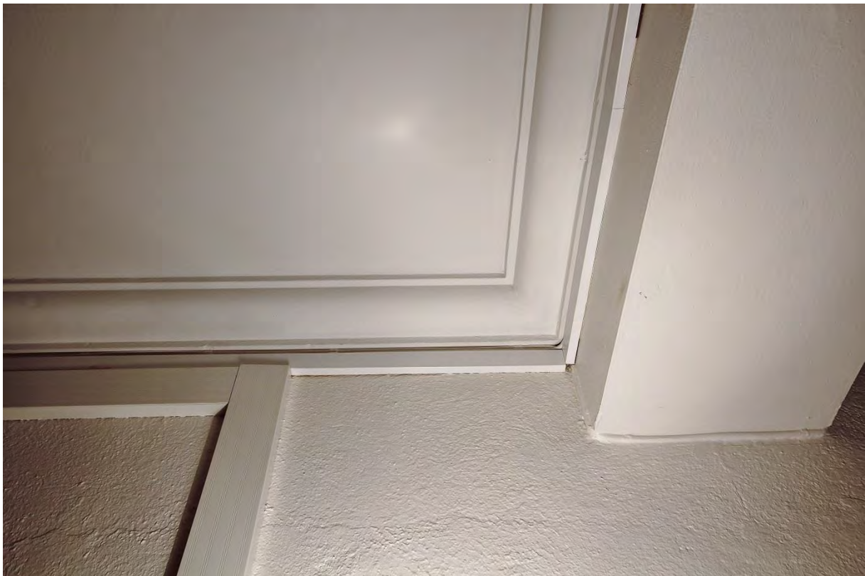
Tak och andra detaljer är slätputsade medan väggarna har en grövre puts. Putsutförandet bedöms vara original.
