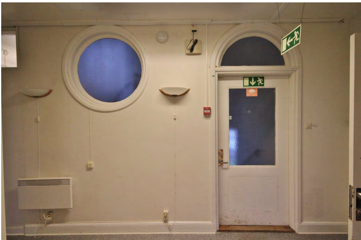
Rum 04.431. Vy mot gårdstrapphuset. Sockel, foder, dörr- och fönsteromfattning är original. Dörr och fönsterglas är utbytta.
