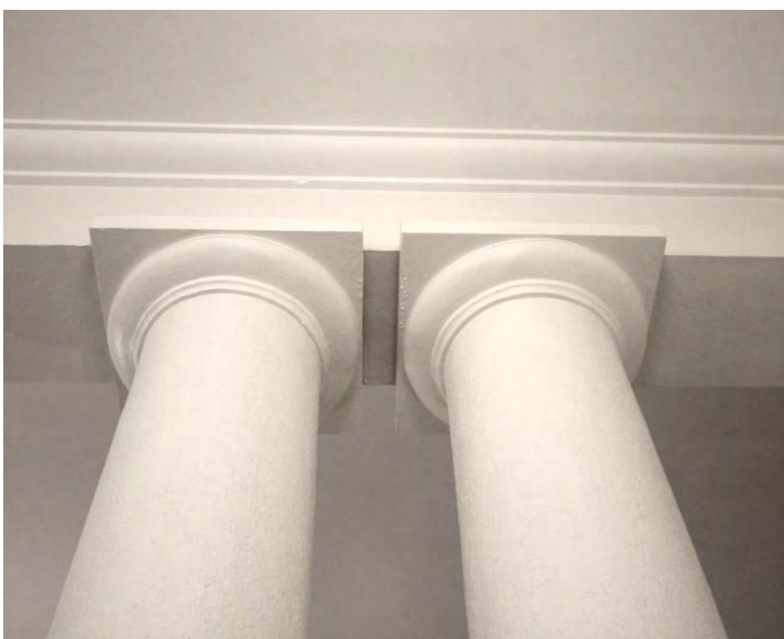
Kolonnerna är grovt putsade och avslutas mot taket med ett enkelt doriskt kapitäl.
