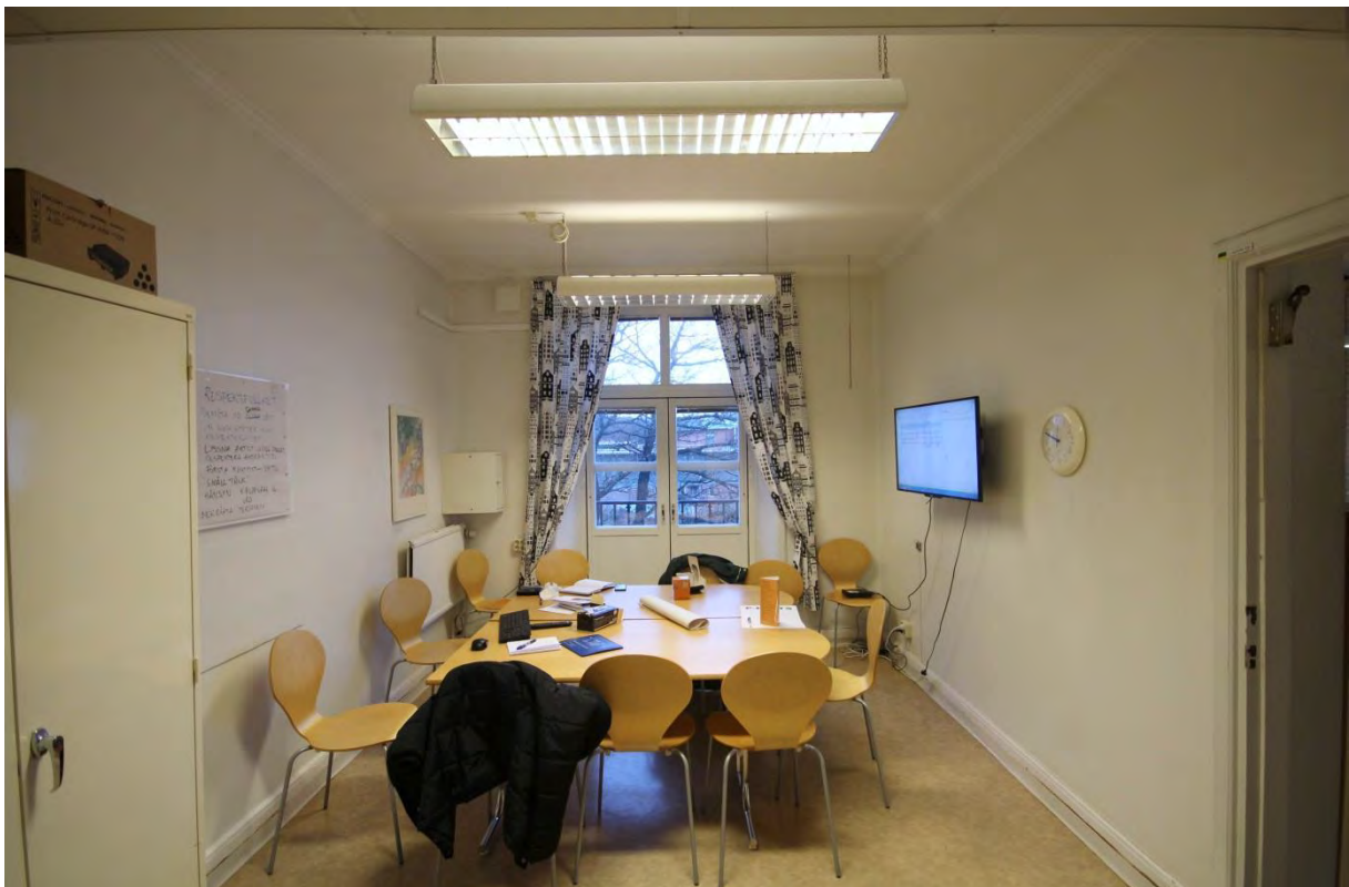
Rum 04.425. Rummet var ursprungligen en del av korridoren och fungerade som dagrum. Det finns bevarade originaldetaljer i form av socklar, foder, dörr, taklist och putsat tak.
