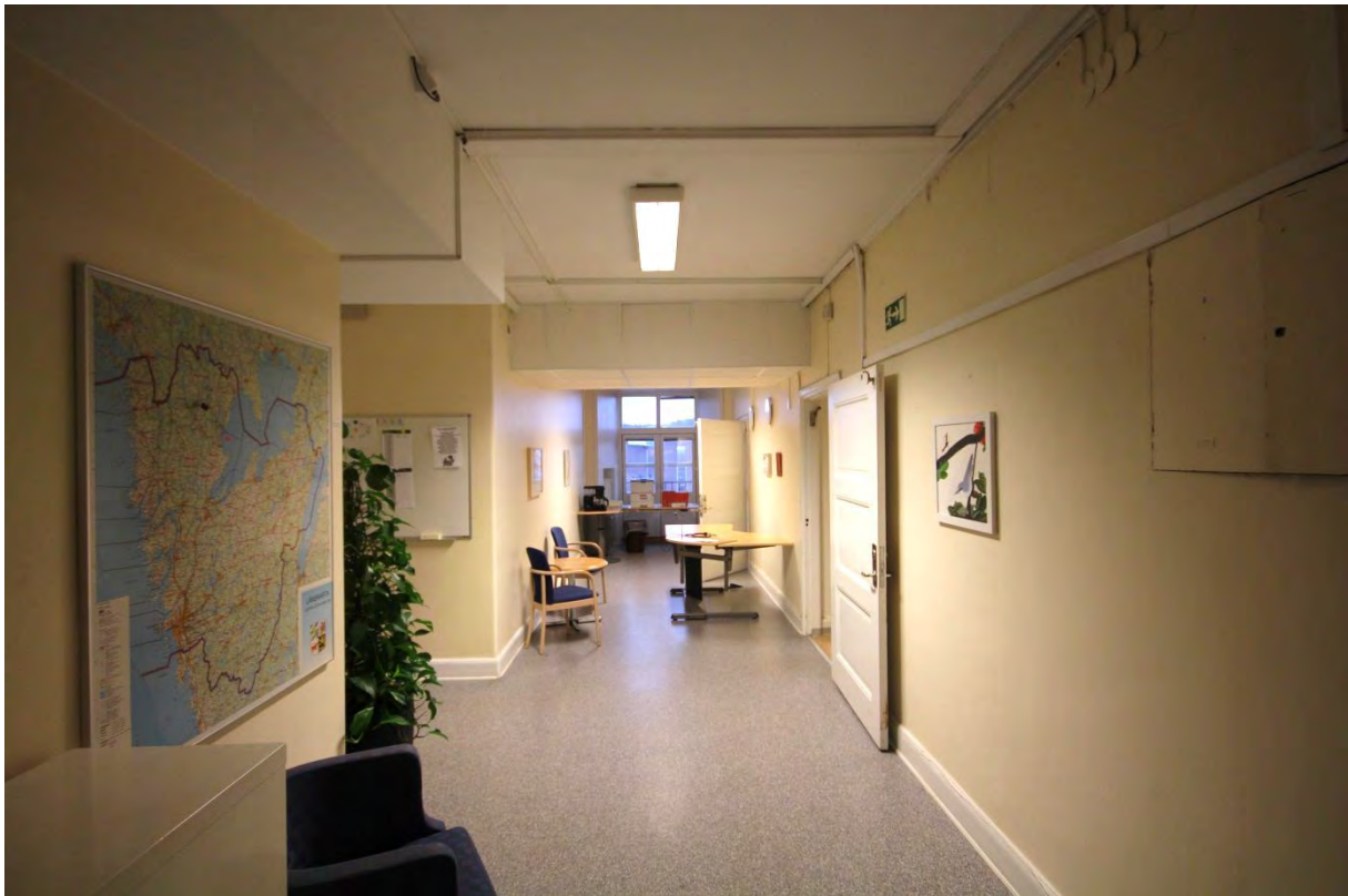
Rum 04.402. Korridoren leder till en balkong i södra fasaden. Rumsindelningen är original och det finns bevarade originaldetaljer i form av socklar, foder, dörrar, taklist och putsat tak.
