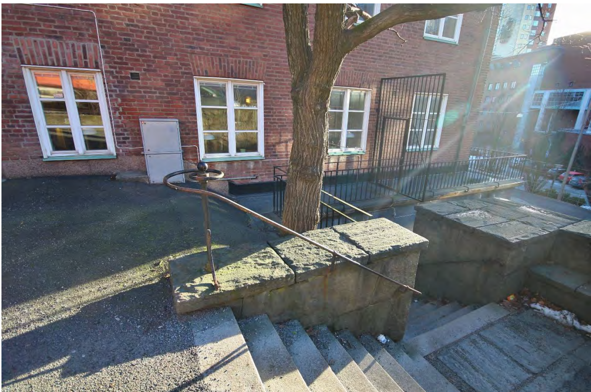
För att hantera höjdskillnaderna i anslutning till byggnaden finns stentrappor med eleganta handsmidda räcken. Fotot visar trapporna vid den västra fasaden.
