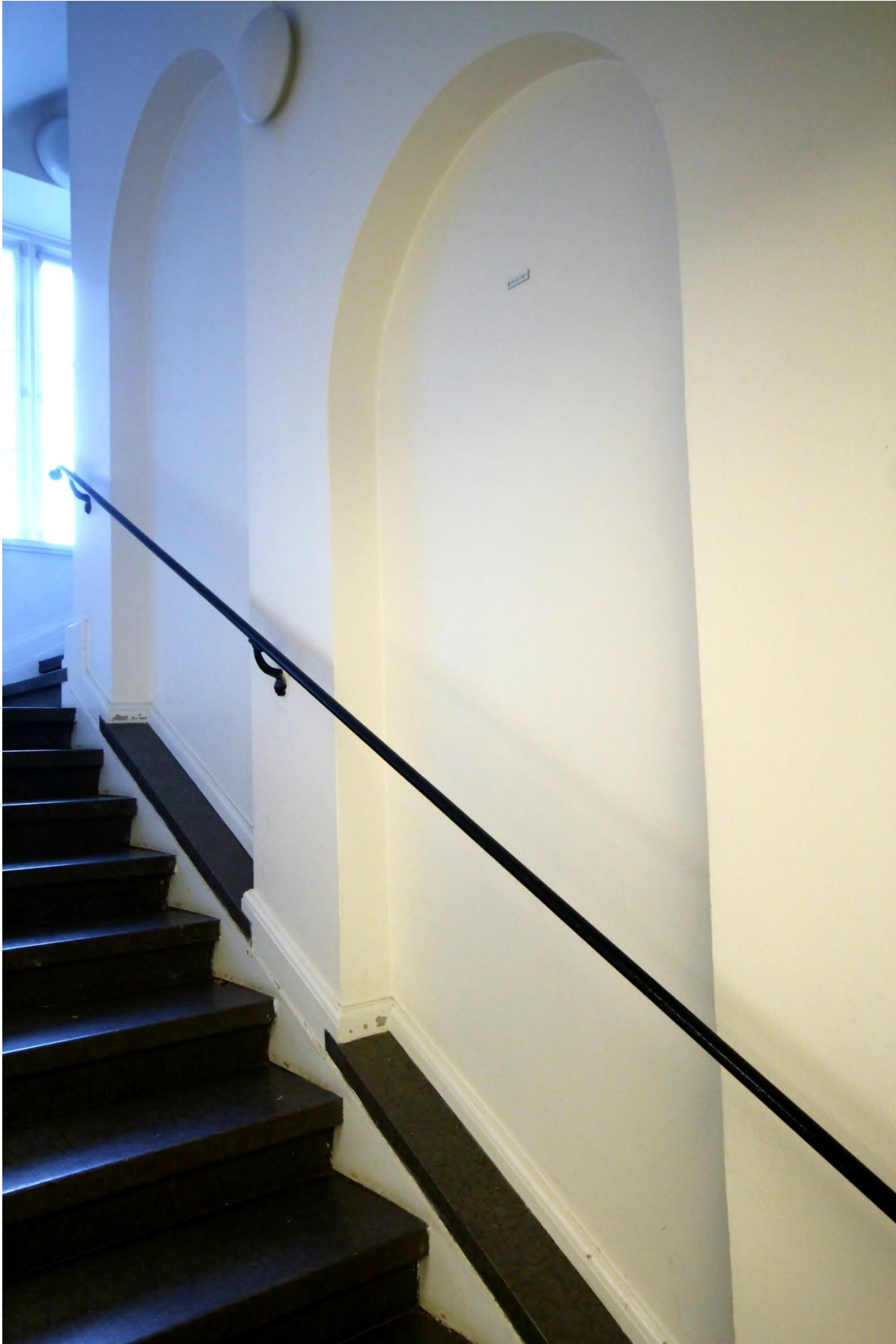
Kalkstentrappa, välvda nischer och handledare i smidesjärn. Samtliga delar är original.
