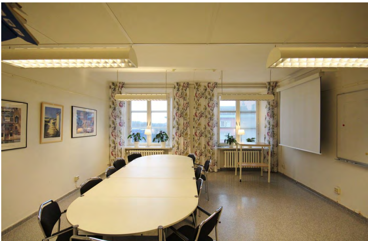
Rum 05.514. Rum som slagits samman av två mindre rum. Rummet har bevarade fönsterbänkar, fönsterfoder, taklister och putsat tak med en senare ventilationskanal mot korridoren.
