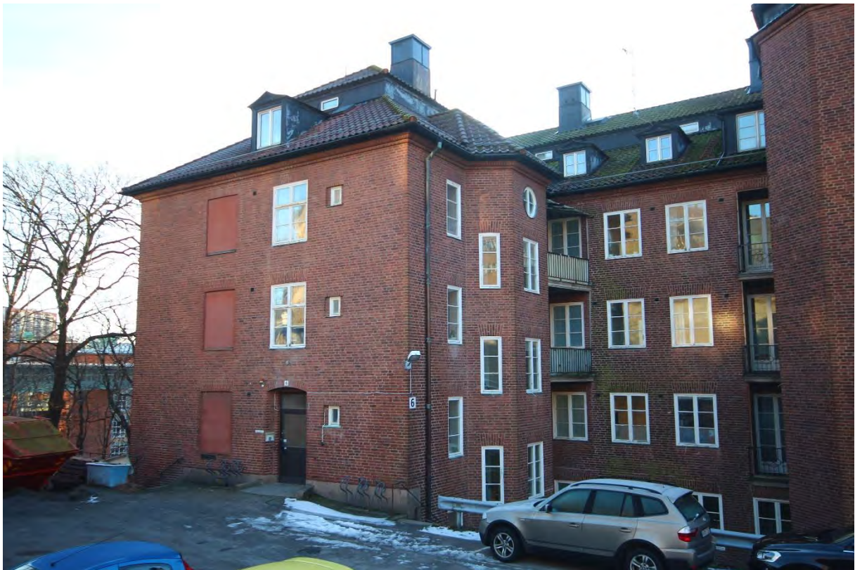
Fasad mot norr med östra flygeln. Några fönster har satts igen.
