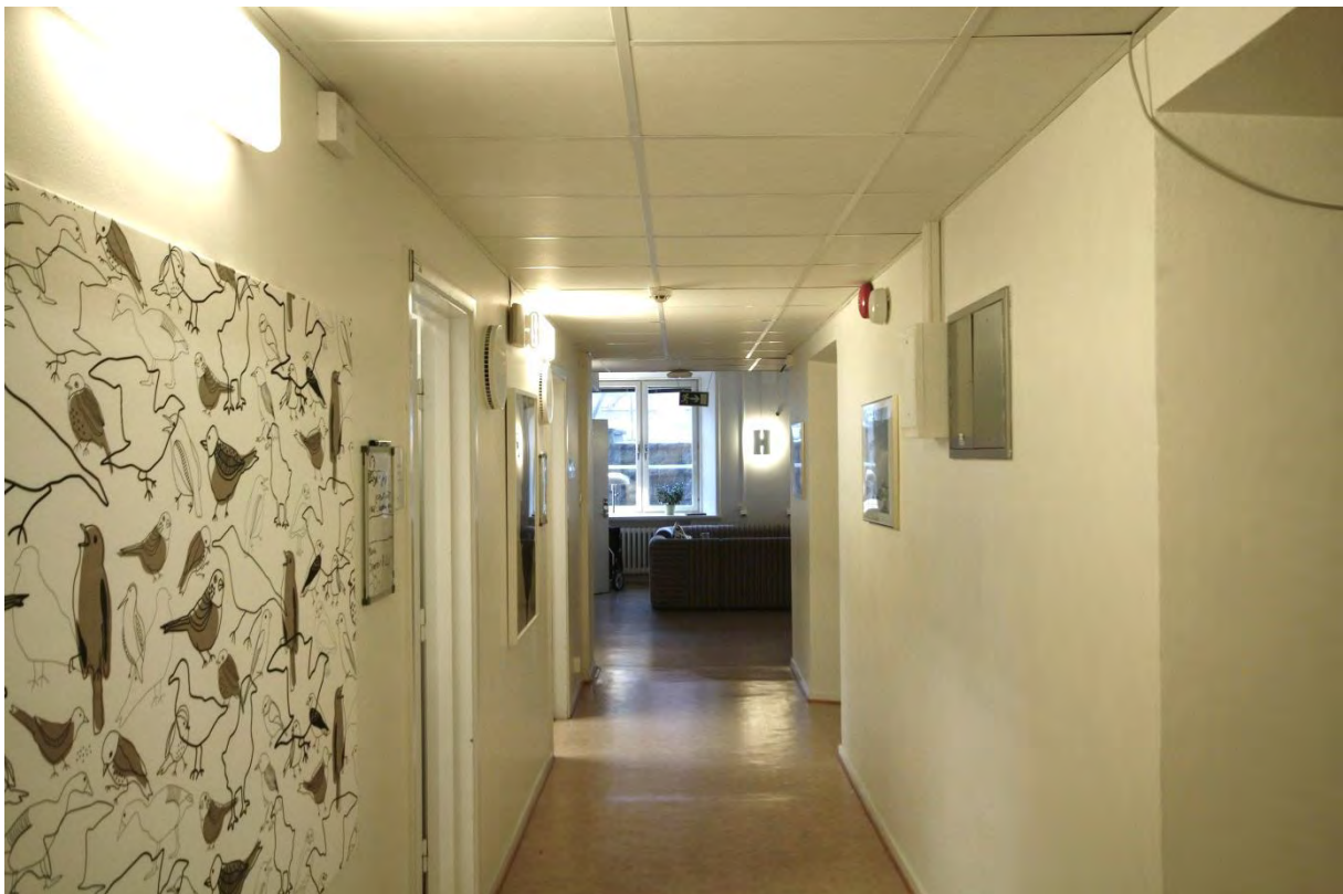
Korridoren 01.102 delades av från rummen mot gatan 1965. De putsade bärande väggarna till höger i bild är original.
