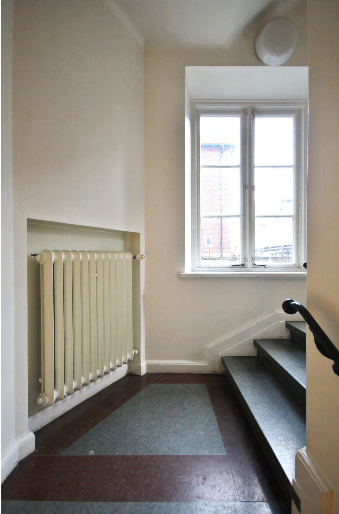
Vilplan i grå kalksten med fris i röd kalksten samt spröjsat tvåluftsfönster mot gården. Samtliga delar i bild är original.
