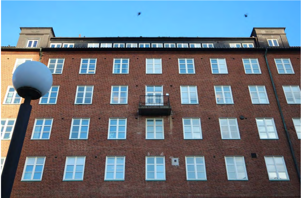
Rött tegel murat i munkförband med takfot av rundat formtegel.
