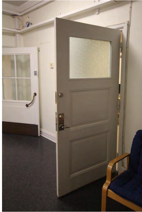
Spegeldörr, sockel och foder – original. Den övre spegeln har försetts med trådglas i senare tid.
