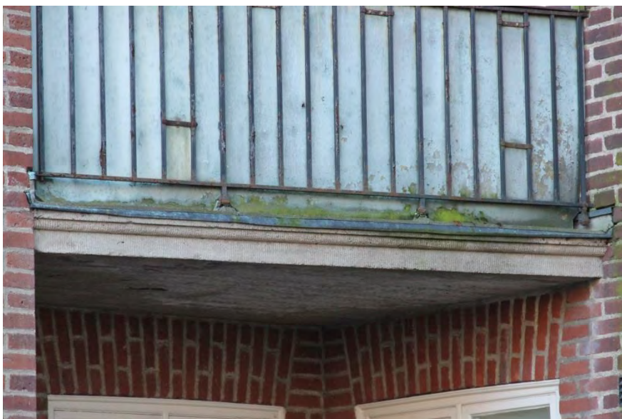
Rostande smidesräcke till följd av eftersatt underhåll.
