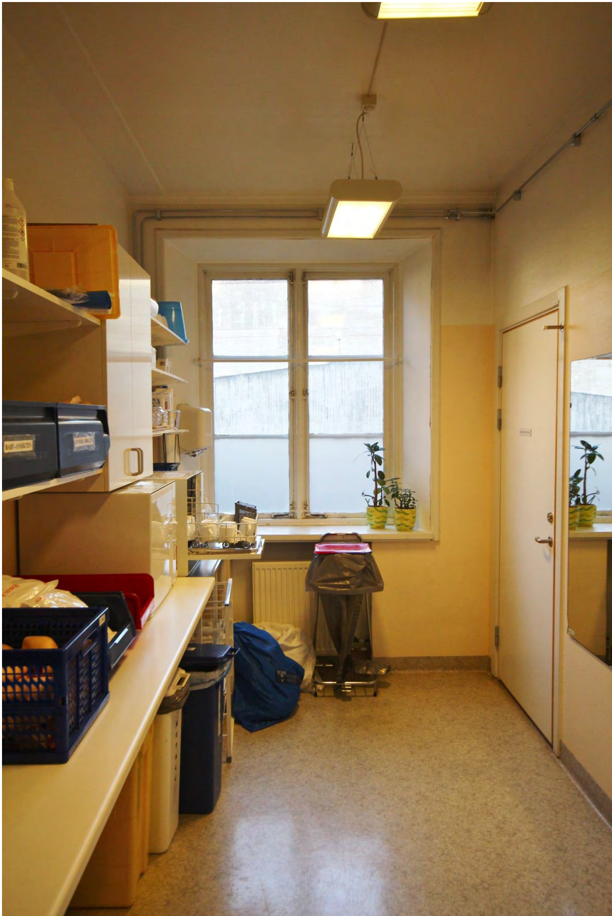
Rum 03.336. Senare inredning med rum för wc och dusch till höger i bild. Fönster, foder och fönsterbänk – original.
