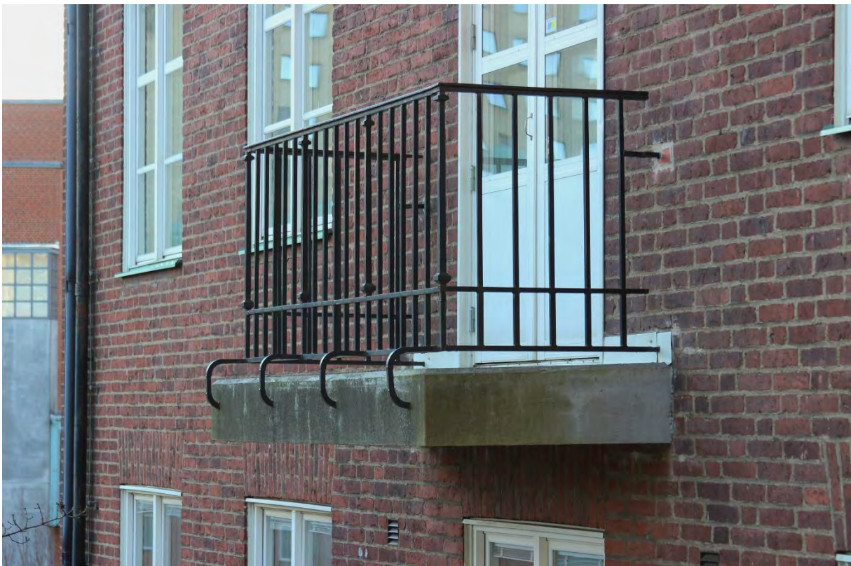
De utanpåliggande balkongerna har utbytta balkongplattor och smidesräcken.
