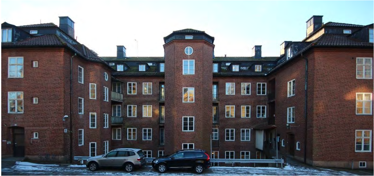
Fasad mot norr med det centralt placerade trapphuset.
