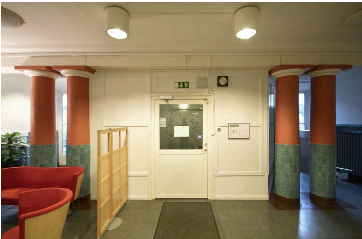
Vy mot trapphus och sekundär vägg flankerad av putsade kolonner med kakelbröstning som bär upp en balk. Bakom dessa finns fönsterdörrar till vädringsbalkonger mot gården (norr). Samtliga delar är original utom vägg mot trapphus.
