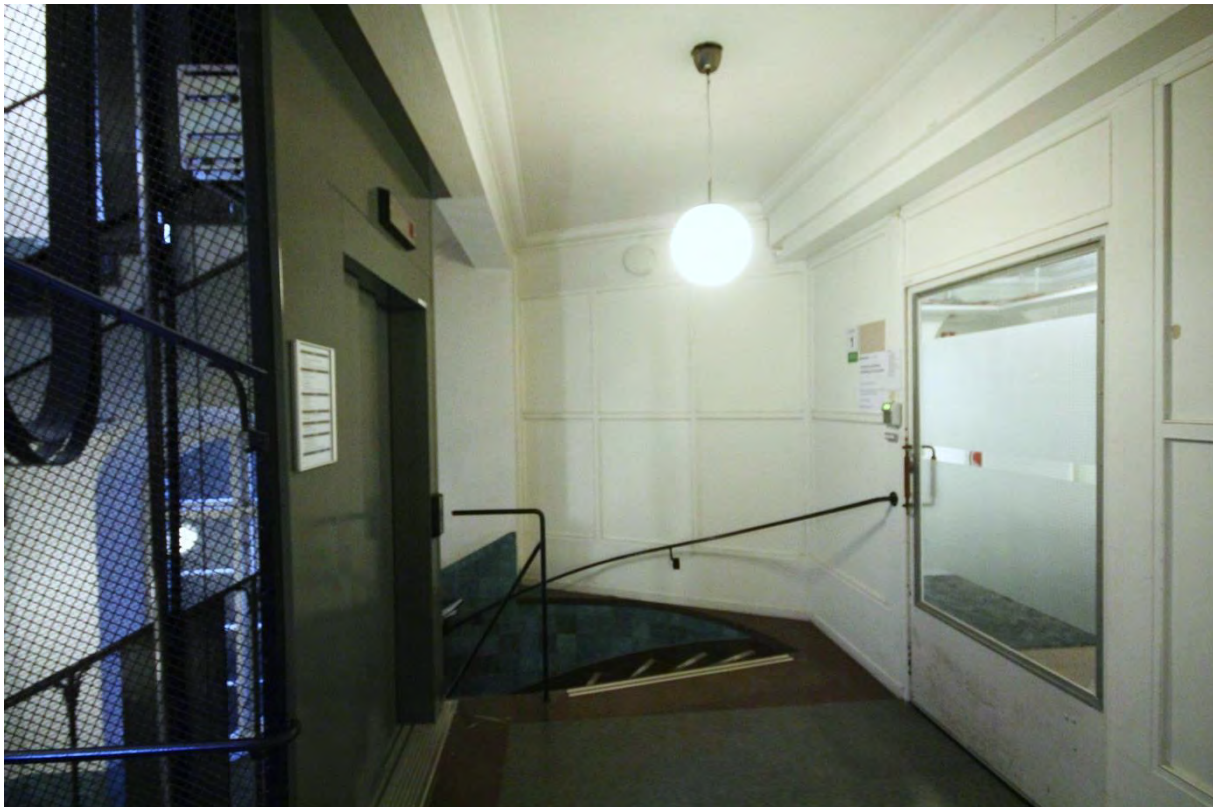
Rum 01.100. Del av den ursprungliga vestibulen som numera utgör en del av trapphuset. Till höger och rakt fram syns sekundär vägg och förlängd handledare i smide. Till vänster i bild syns ursprungligt hisschakt med utbytt front och hissorg.
