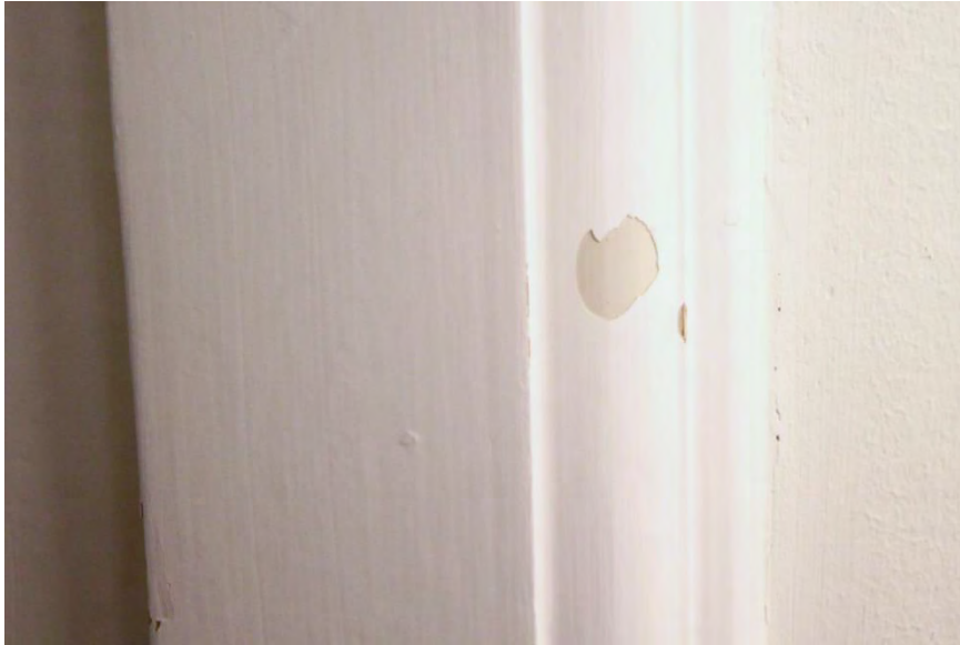
Färgsläpp på snickeridetalj, plan 3. Snickerierna har i allmänhet påfallande få färgskikt. På bilden syns ursprunglig linoljemålad yta under lackfärg.
