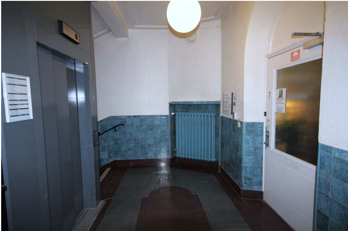
Rum 04.400. Vilplan med ursprunglig rumsindelning. Originalmaterial av hög kvalitet i form av golv i röd och grå kalksten och kakelbröstning.
