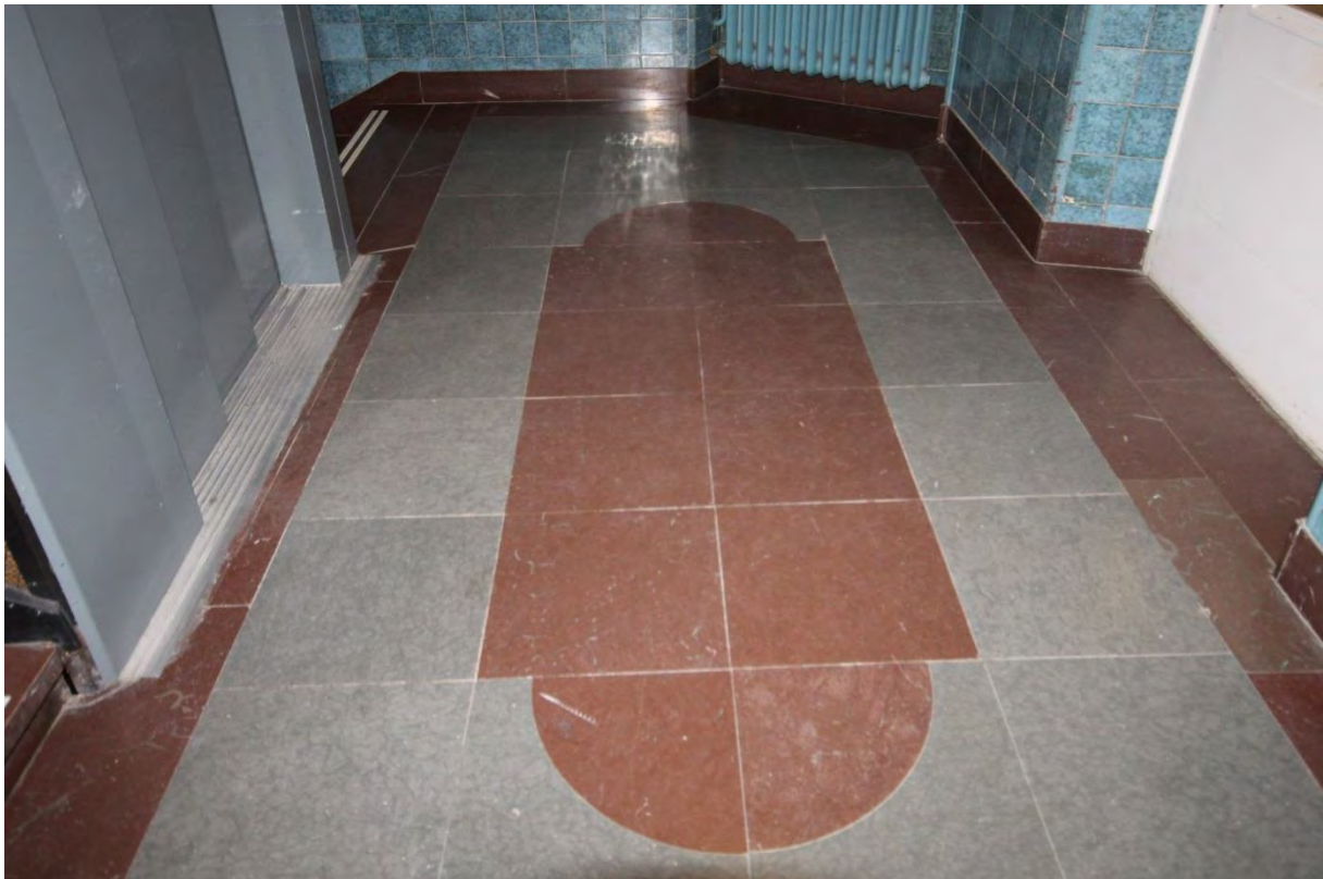
Plan 3. Kalkstensgolv i grå kalksten med fris och sockel samt intarsia i röd kalksten.
