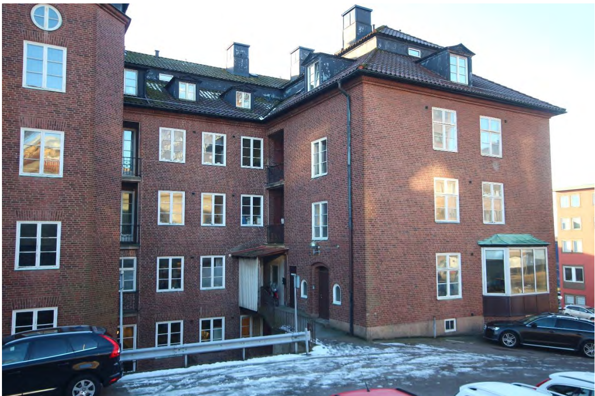
Fasad mot norr med västra flygeln.
