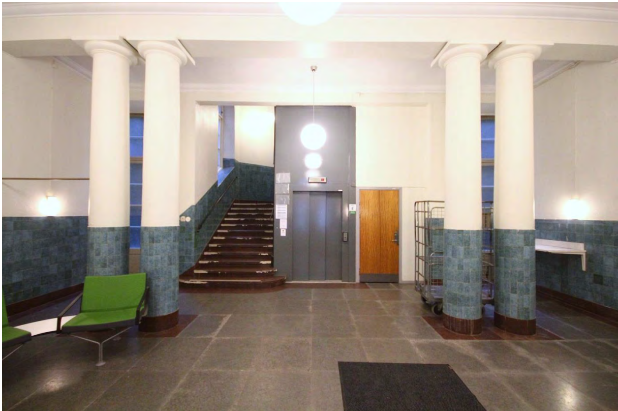
Rum 00.003a. I vestibulen är markplanets högre takhöjd särskilt märkbar. Vestibulen har kalkstengolv samt sockel lika entrén, kakelbröstning samt putsade väggar och tak. De parställda kolonnerna bär upp en tvärgående balk.
