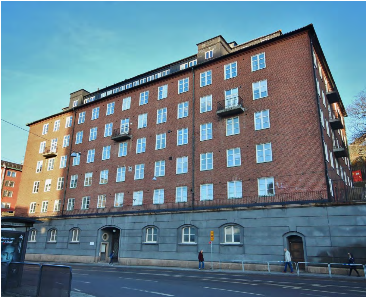
Fasad mot söder. Byggnaden är belägen i suterräng och har en hög putsad sockelvåning som även fungerar som terrass.
