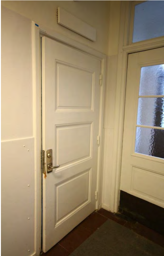
Originaldörr mot rum 03.330 samt vindfång 03.329.
