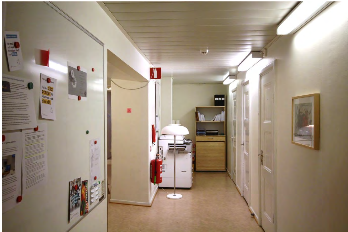
Rum 01.102. Passage som utgör en del av ursprunglig rumsindelning med spegeldörrar till höger i bild som är original respektive äldre kompletteringar.
