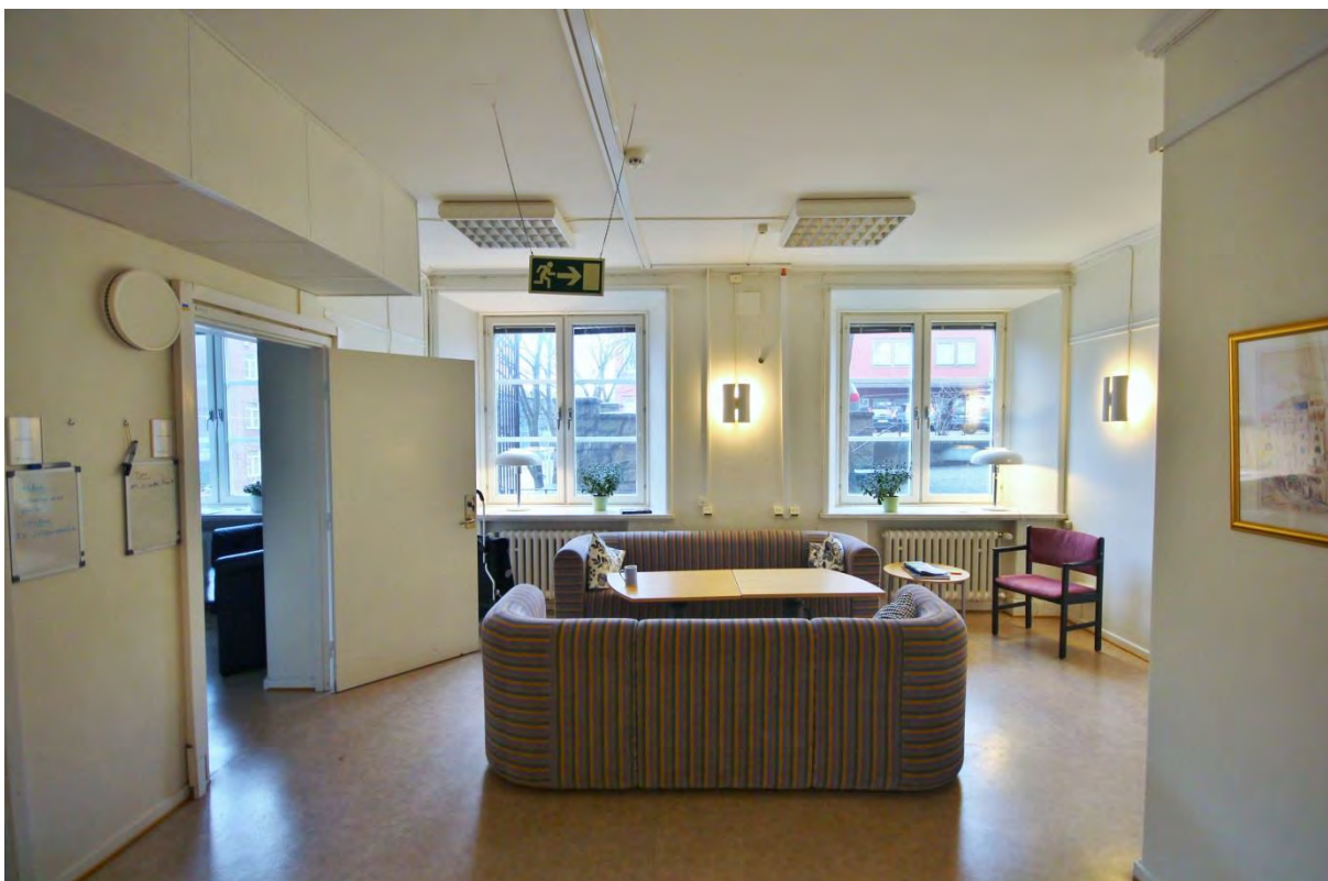
Rum 01.112 är ett originalrum som tidigt delats av i ett mindre förråd (109). Mot ytterväggen finns originaldetaljer i form av sockel, fönsterfoder och fönsterbänk. I taket finns synlig originaltaklist utom vid inbyggd ventilation.
