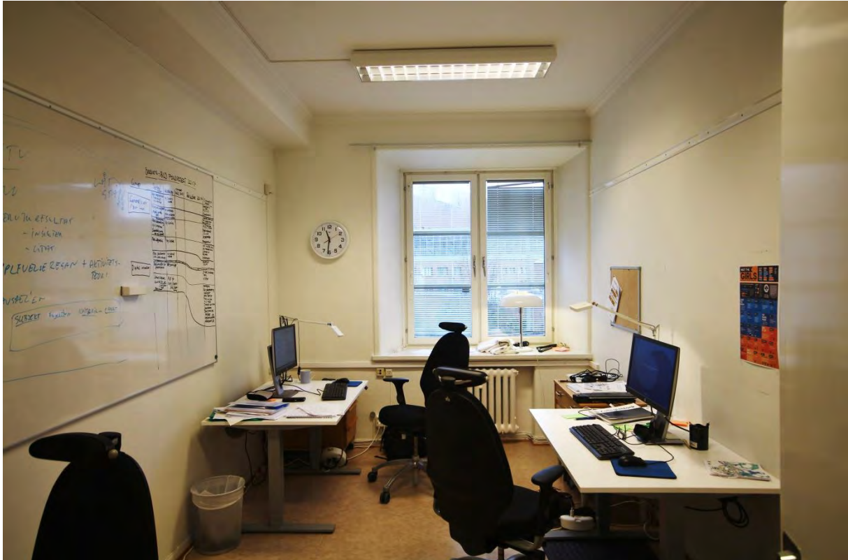
Rum 01.116. Rumsindelningen är från 1965, men balken i taket till vänster i bild är original. Planlösningen var utformad med stora rum som kunde delas av till mindre rum med lättväggar.
