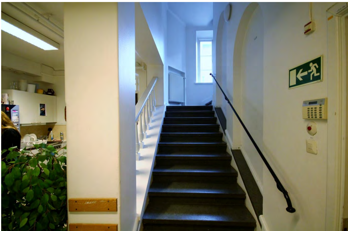
Rum 02.237. Trappa mot gårdstrapphuset i grå kalksten, vitmålat trätäckte med svarvade balusterdockor och handsmidd handledare. I den putsade väggen finns välvda nischer. Samtliga delar är original.
