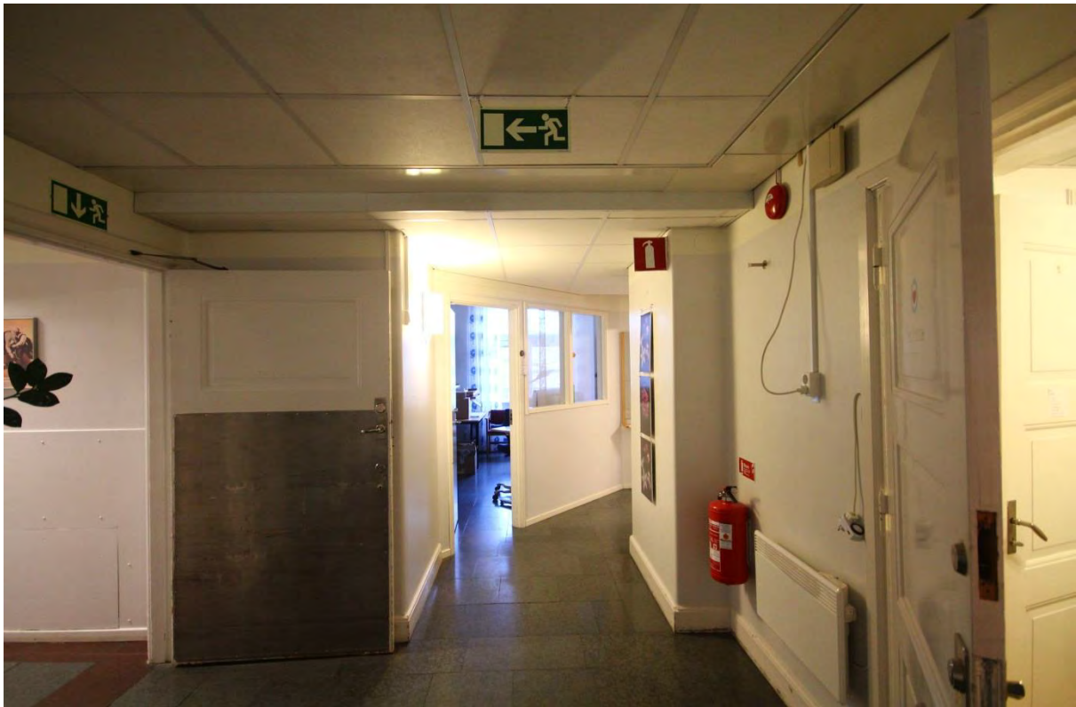
Vy mot rum 03.333. Den sneda väggen rakt fram i bilden är sekundär och ursprungligen fanns ingen vägg mellan korridor och väntrum. Kalkstengolvet fortsätter in i rum 333.
