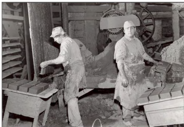
Tillverkning av handslaget tegel på Helsingborgs Ångtegelbruk. (Kringla)
