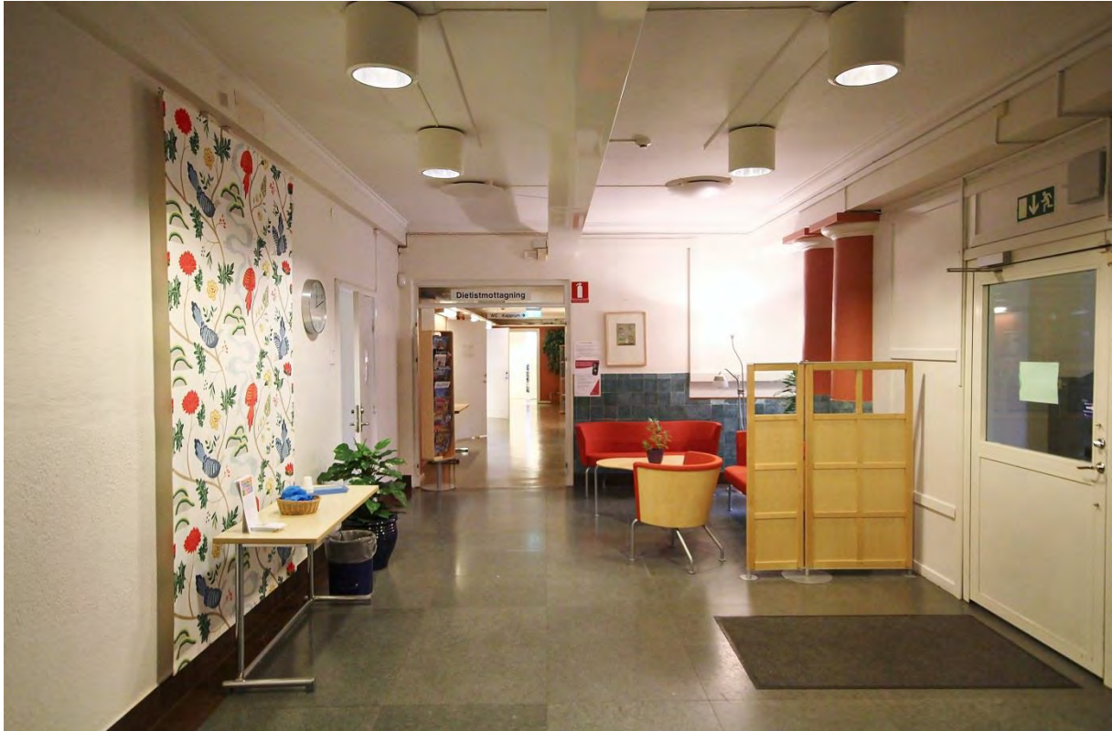
Rum 02.201. Vestibul med originalinslag i form av kalkstengolv, putsade väggar, kakelbröstning och putsat tak med kraftig taklist. Till höger i bild sekundär vägg mot trapphus.
