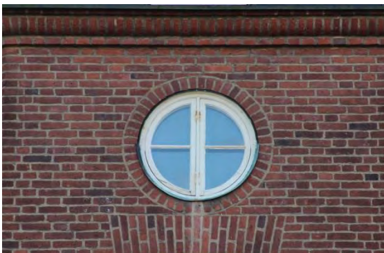
Runt fönster – så kallat oxöga – med två lufter och liggande spröjs. Mönstermurning och takfot med formtegel utfört i handslaget Helsingborgstegel.
