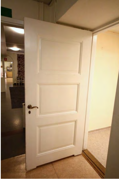
Spegeldörr mot rum 01.132a. Dörren är original men möjligen flyttad.
