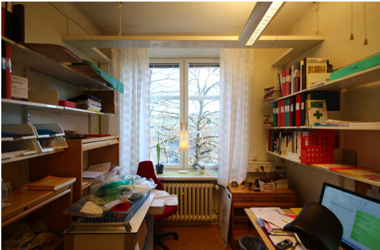
Rum 03.325. Rummet var ursprungligen större och är avdelat i senare tid. Det finns bevarade material och detaljer som sockel, foder, fönsterbänk, radiator och putsat tak.
