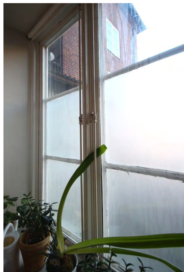
Rum 03.304. Mot gården finns originalfönster med utanpåliggande spanjolett.
