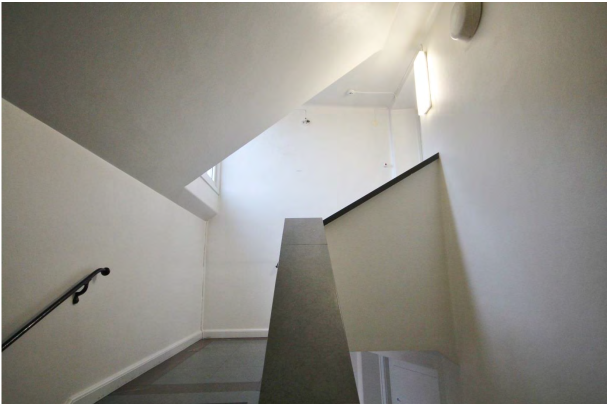
Översta våningsplanet har snedtak och trappspindeln avslutas i ett kraftigt räcke avtäckt med kalkstensskivor. Samtliga byggnadsdelar i bilden är original.
