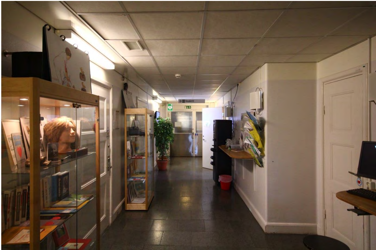
Rum 03.334. Korridoren har originalplanlösning och till stora delar bevarade originalmaterial och -detaljer som kalkstensgolv, socklar, spegeldörrar och foder.
