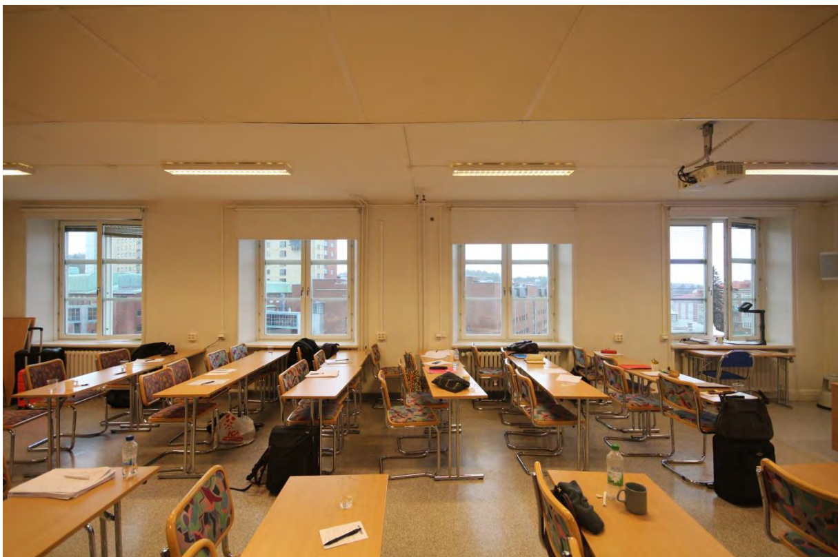
Rum 05.522. Två större sjuksalar som slagits samman till ett konferensrum. Socklar, foder, dörrar, fönsterbänkar och radiatorer är original.
