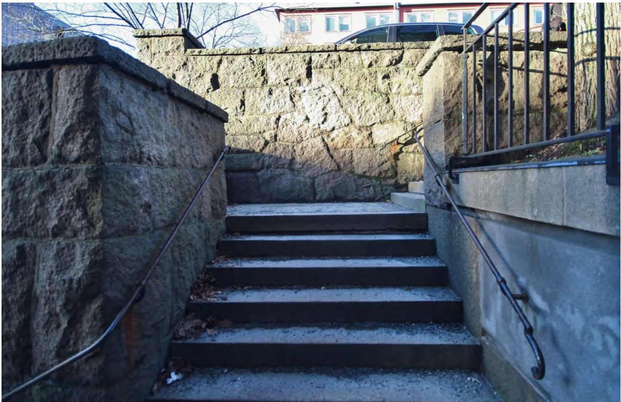
Stödmurar klädda med natursten – original.
