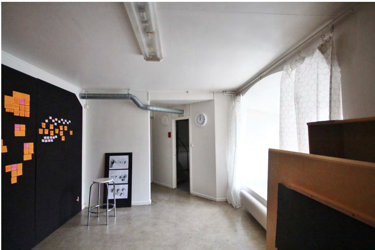
Rum 00.016. Vy mot öster. Fönster och radiator utgör enda äldre detaljer i rummet som har förändrad planlösning.
