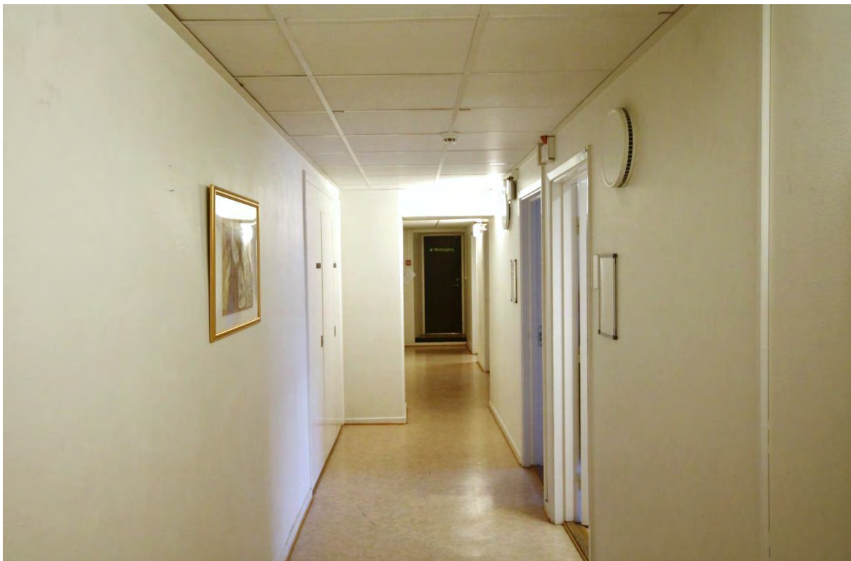
Korridoren 01.134 delades av från rummen mot gatan 1965. De putsade bärande väggarna till vänster i bild är original.
