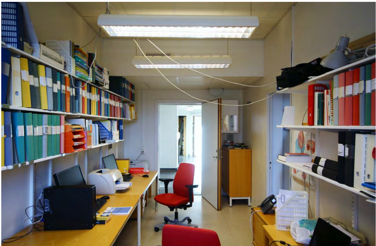
Rum 03.312. Rummet har utbytt dörr och en ventilationskanal i taket mot korridoren. Samma gäller för resterade rum 310-318.
