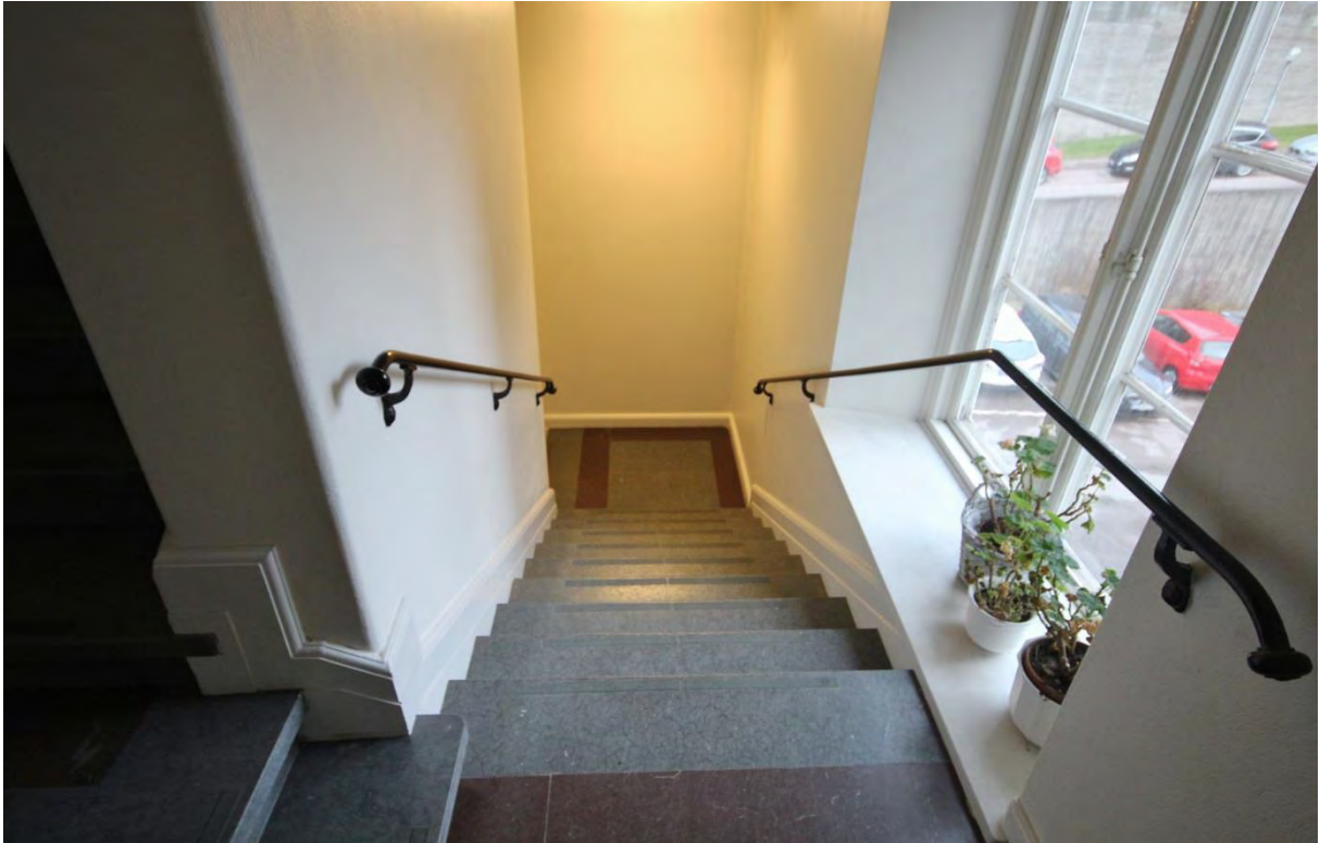
Spröjsat tvåluftsfönster med spanjolett. Samtliga byggnadsdelar i bilden är original.
