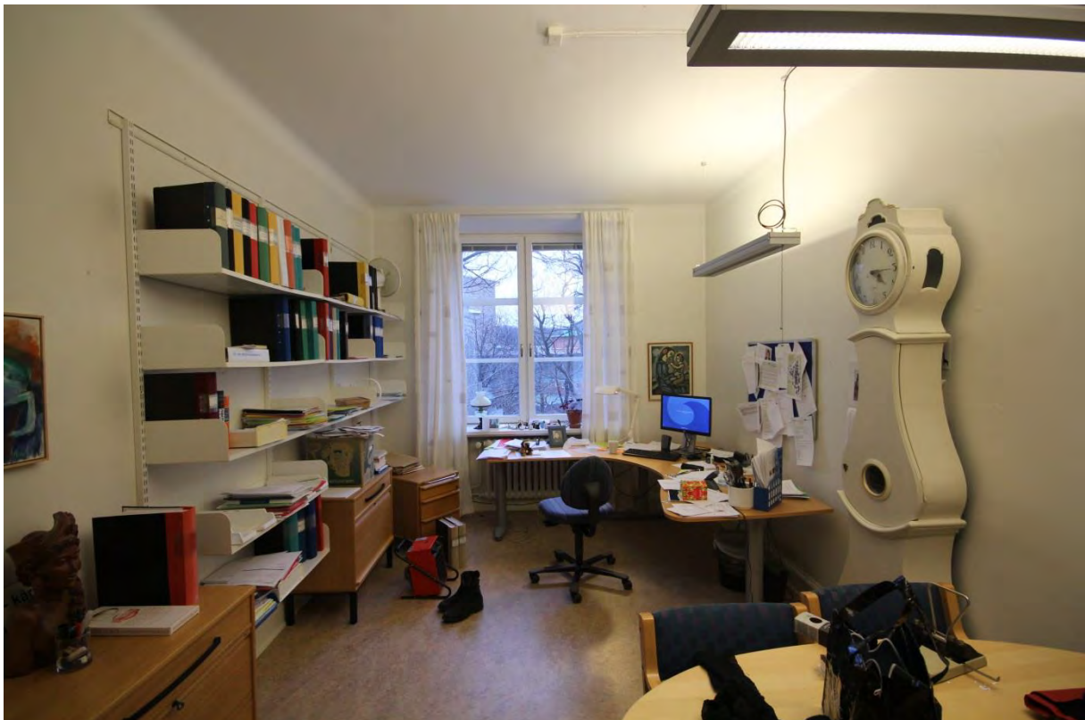
Rum 04.427. Rummet har delats av från en större sjuksal. Det finns bevarade originaldetaljer i form av socklar, foder, fönsterbänk och radiator.
