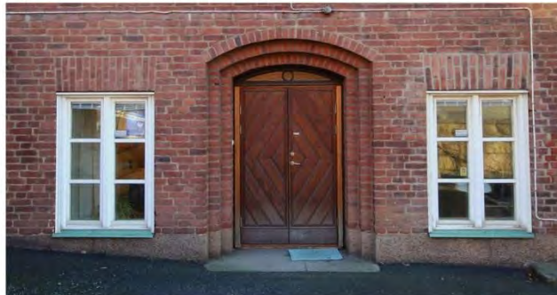
Parti med avtrappad valvbåge i tegel. Exempel på originalentré med utbytt dörr. Överljus i original. Förstorade fönsteröppningar och utbytta fönster på ömse sidor.
