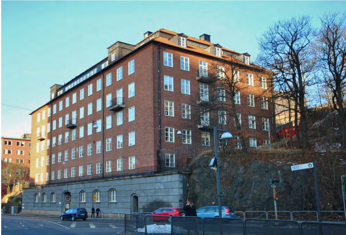
Fasader mot öster och söder.
