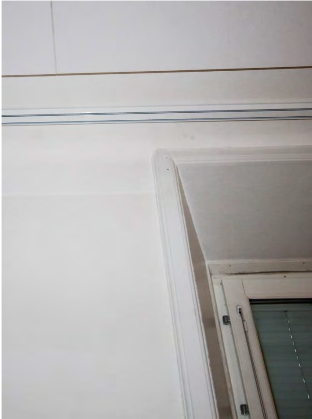
Rum 04.416. Fönsterfoder och putsat tak under akustikplattor – original.
