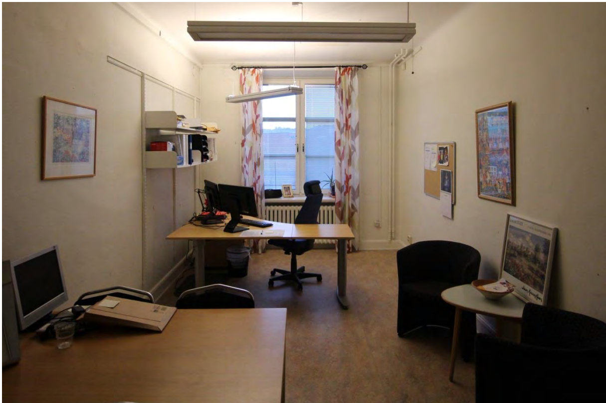
Rum 05.520. Rumsindelningen är original och det finns originaldetaljer i form av sockel, fönsterbänk, foder samt putsat tak och taklist.
