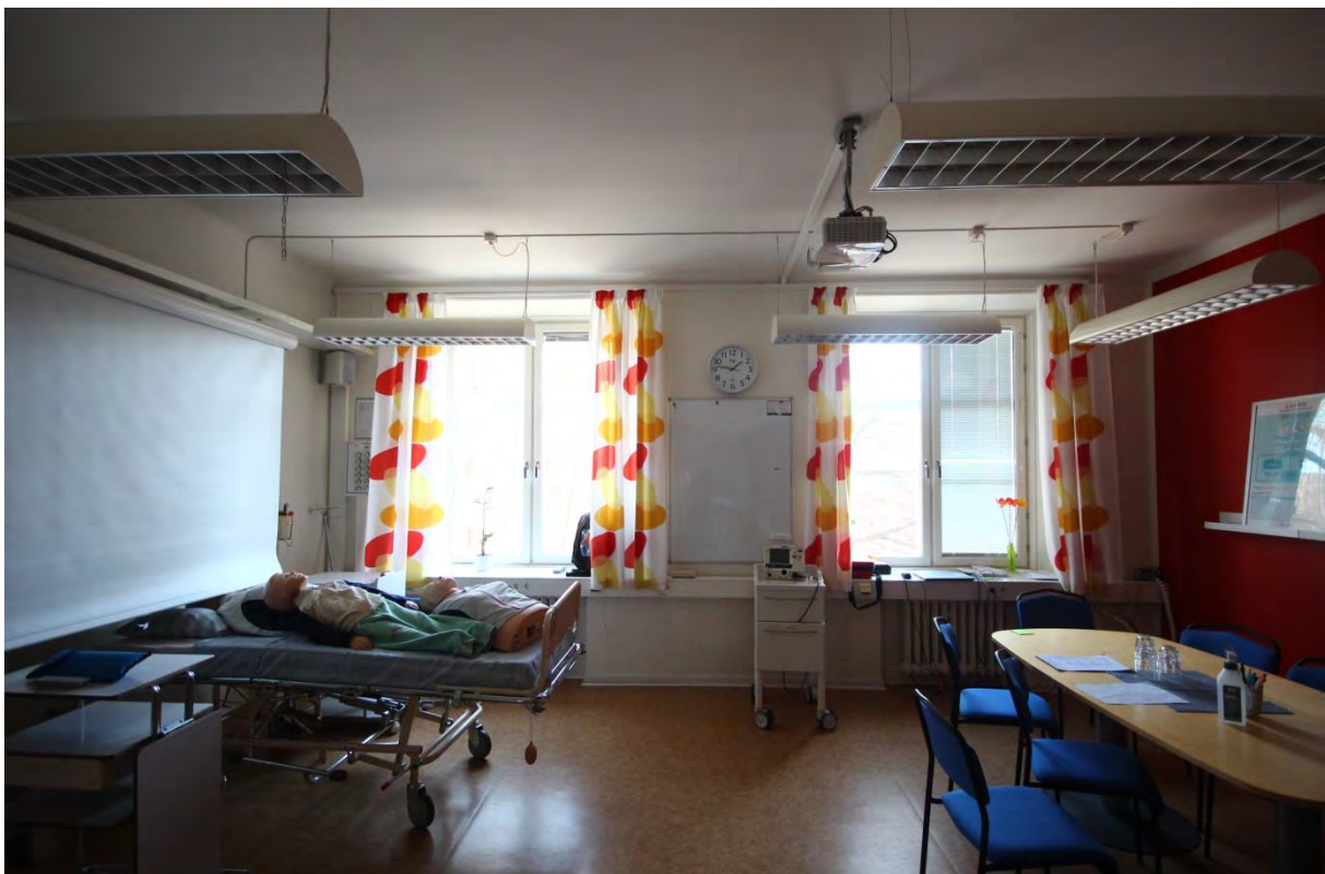
Rum 03.326. Rummet har originalplanlösning med enstaka bevarade material och detaljer som fönsterfoder och radiator samt putsat tak.
