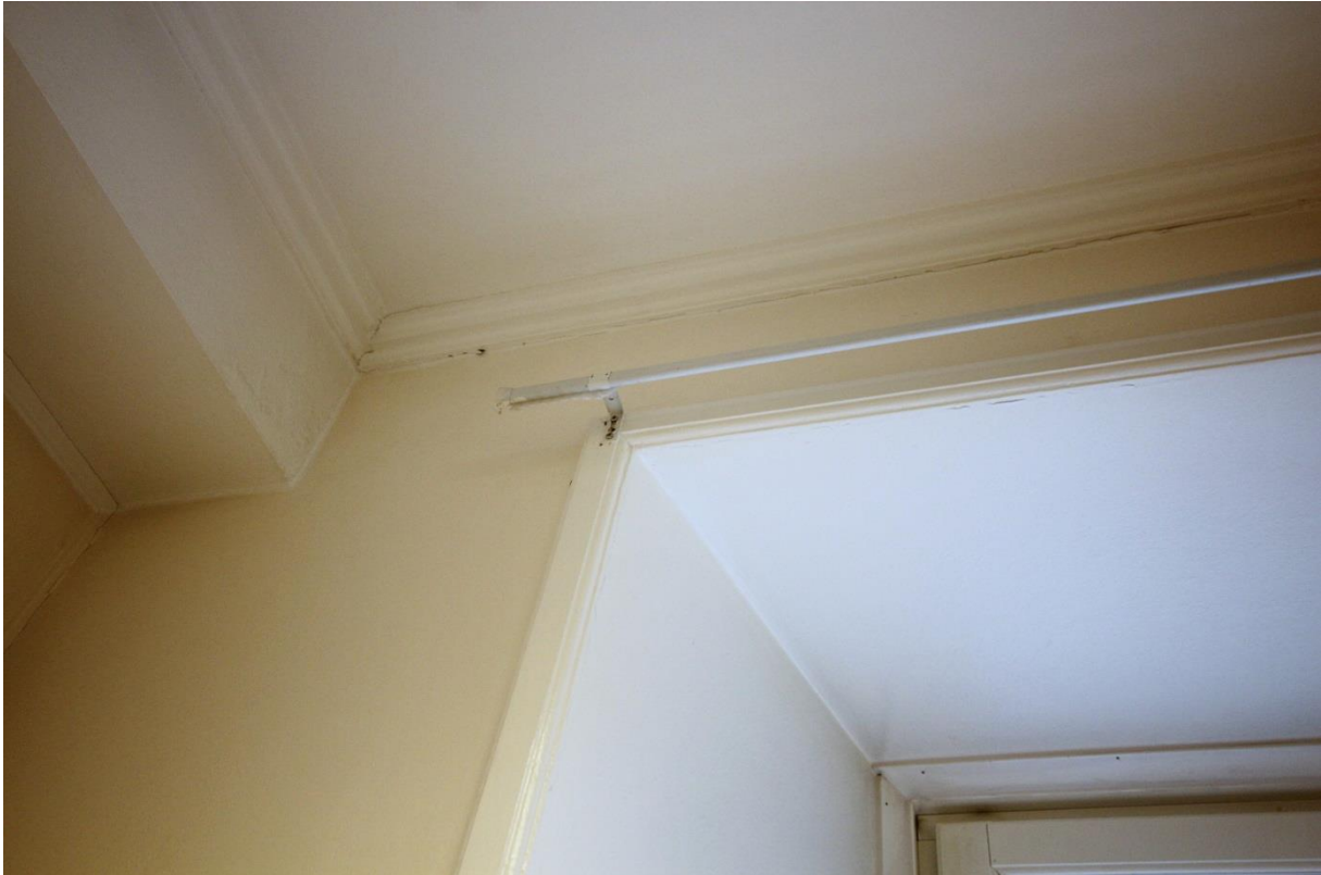
I rum 01.1123-25 finns generellt bevarade originaltaklister. Till vänster i bild syns en originaltaklist utmed yttervägg och takbalk.
