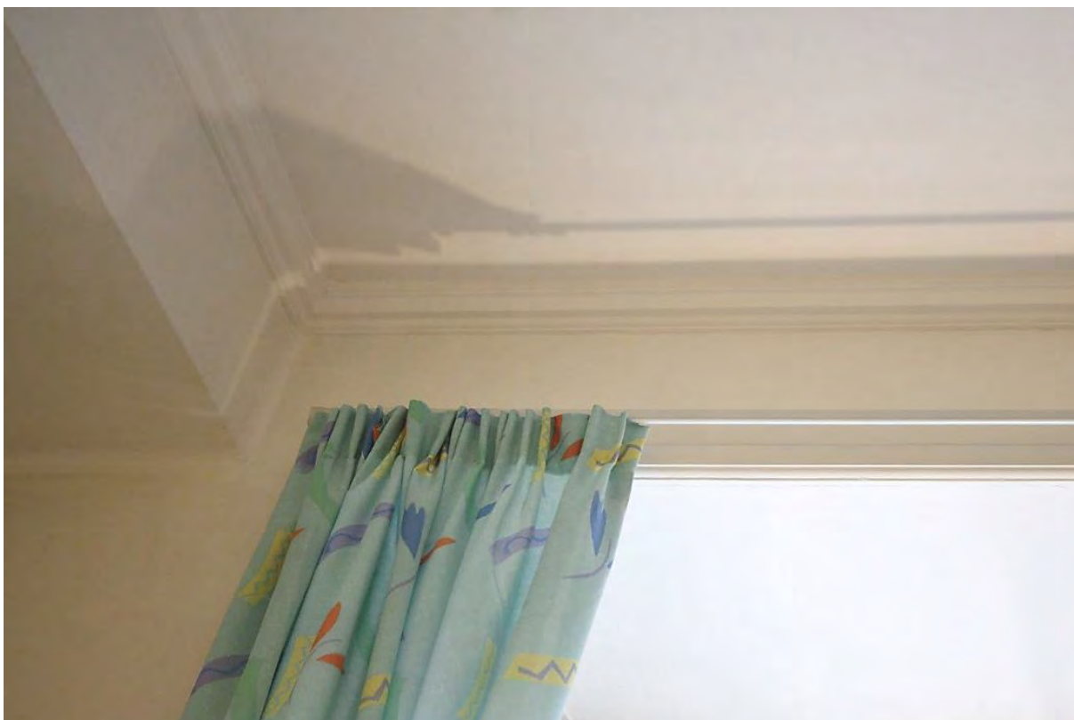
I rum 01.115-120 finns generellt bevarade originaltaklister. Till vänster i bild syns en originaltaklist utmed yttervägg och takbalk.
