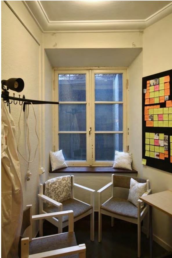
Inåtgående kopplat tvåluftsfönster i trä med liggande spröjs samt fönsterbänk i kalksten. Samtliga delar original.
