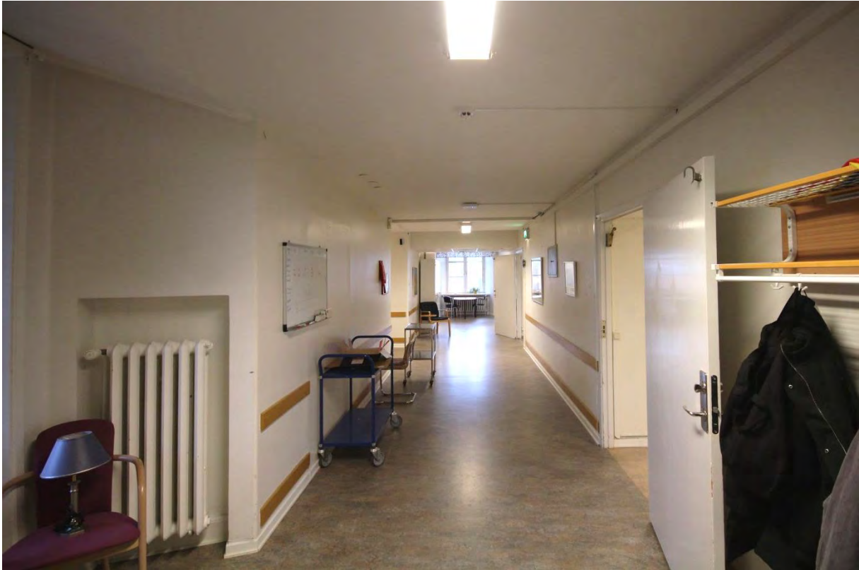
Rum 05.502. Korridoren leder till ett fönster i södra fasaden. Rumsindelningen är original och det finns enstaka originaldetaljer i form dörrar, fönsterdörr, foder och radiatorer.
