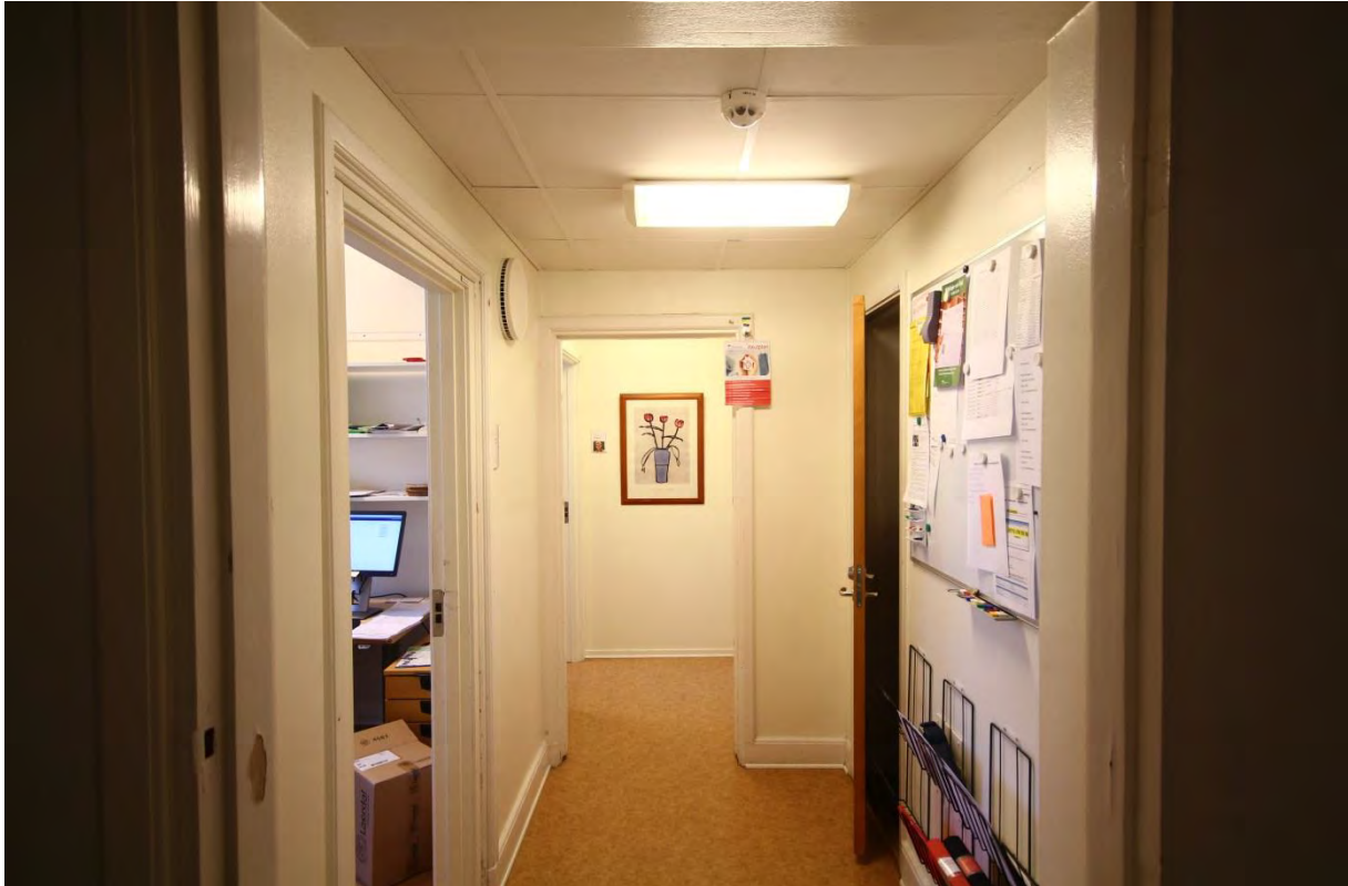
Rum 03.324 a. Rummet har originalplanlösning och det finns bevarade socklar, foder och dörrkarmar.
