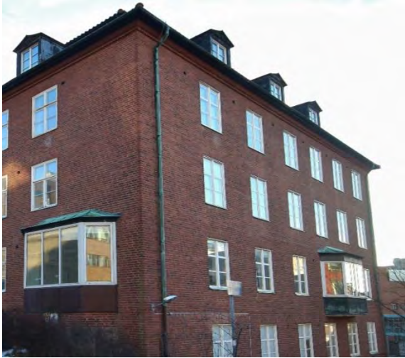
Byggnadens två kantiga burspråk med utbytta fönster och delvis utbytt plåt.
