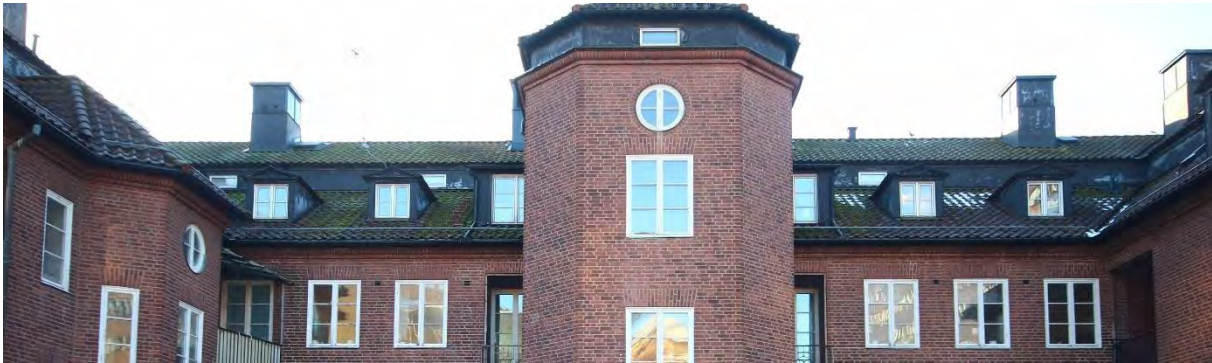
Säteritaket är avtäcktt med enkupigt tegel. Svartmålad plåt återfinns bland annat som avtäckning av de många takkuporna.
