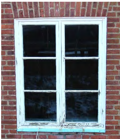
Exempel på originalfönster i olika utförande. Två- respektive enluftsfönster med liggande spröjs samt korspostfönster med liggande spröjs i nedre bågarna. Fönsterbleck i kopparplåt – original.
