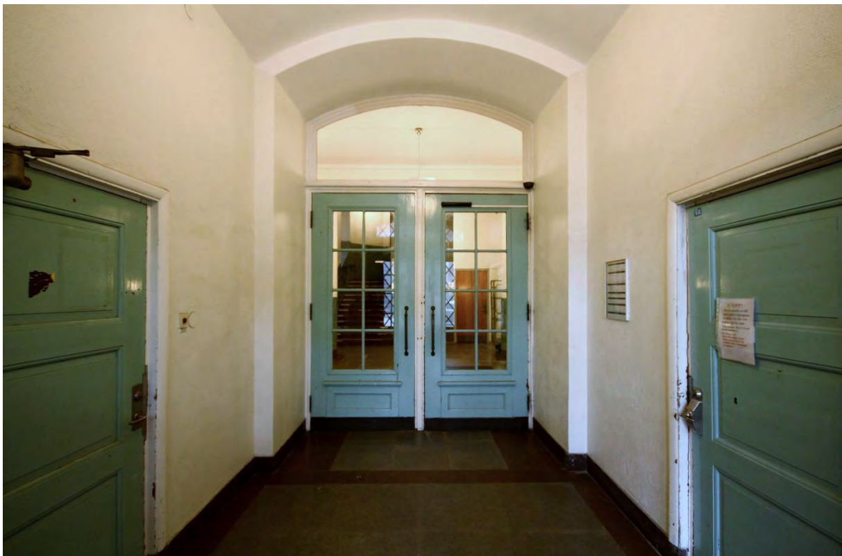
Rum 00.002. Entréhall mot vestibul. Golv i grå kalksten med fris och sockel i röd kalksten. Spegeldörrar och parställda svängdörrar med överljus och profilerade foder – samtliga delar är original.
