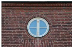
Runt fönster – så kallat oxöga – med två lufter och liggande spröjs.
