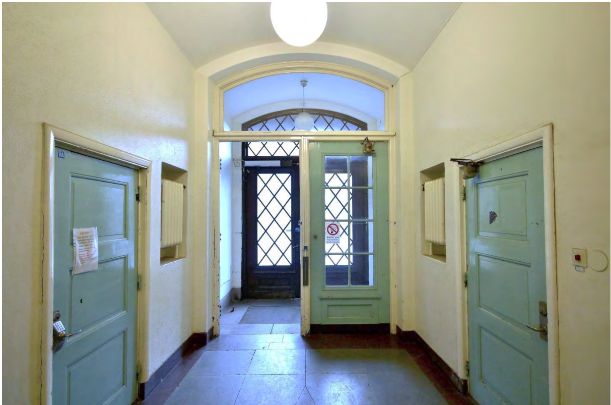
Rum 00.002. Vy mot vindfång och entréparti i ek och glas. Parställda glasdörrar mot vindfånget, varav den ena saknas. Samtliga delar är original.
