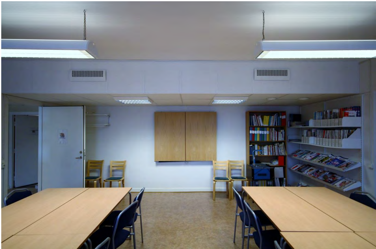
Rum 02.221. Rummen har generellt en installationskanal placerad i taket.
