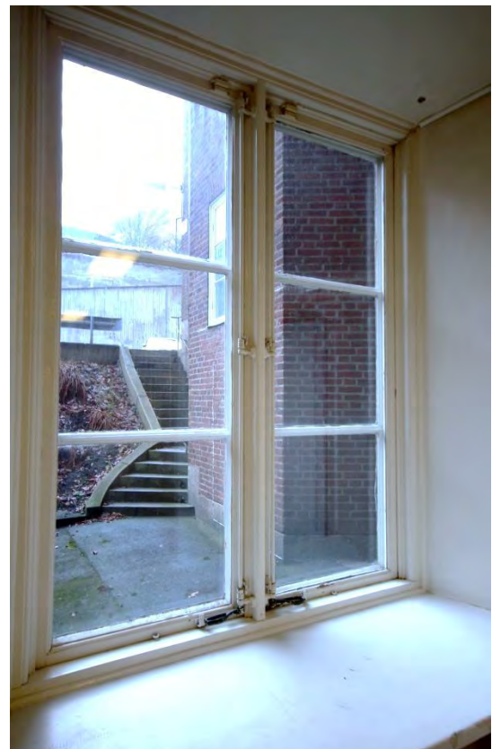
Rum 02.241. Originalfönster med utanpåliggande spanjolett. Dessa är bevarade i alla rum mot gården i rumsavsnittet.
