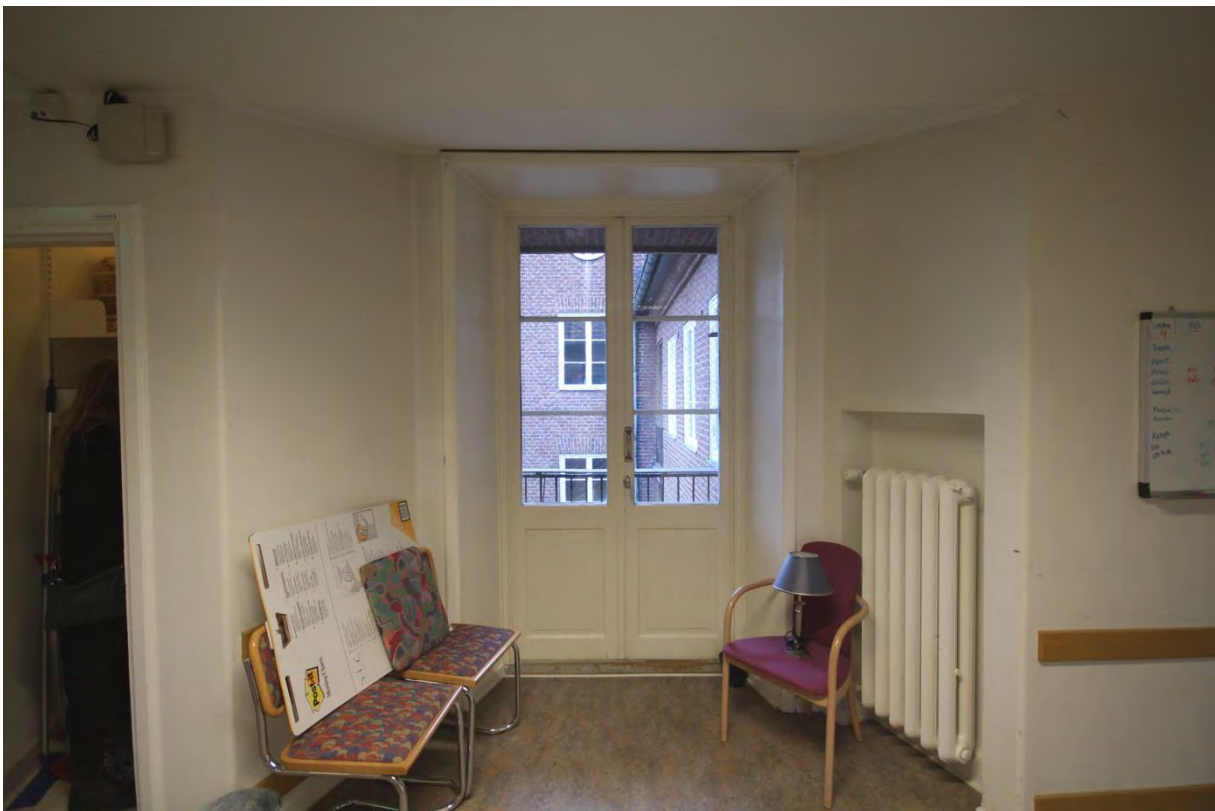
Rum 05.502. Fönsterdörr, foder och radiator – original.
