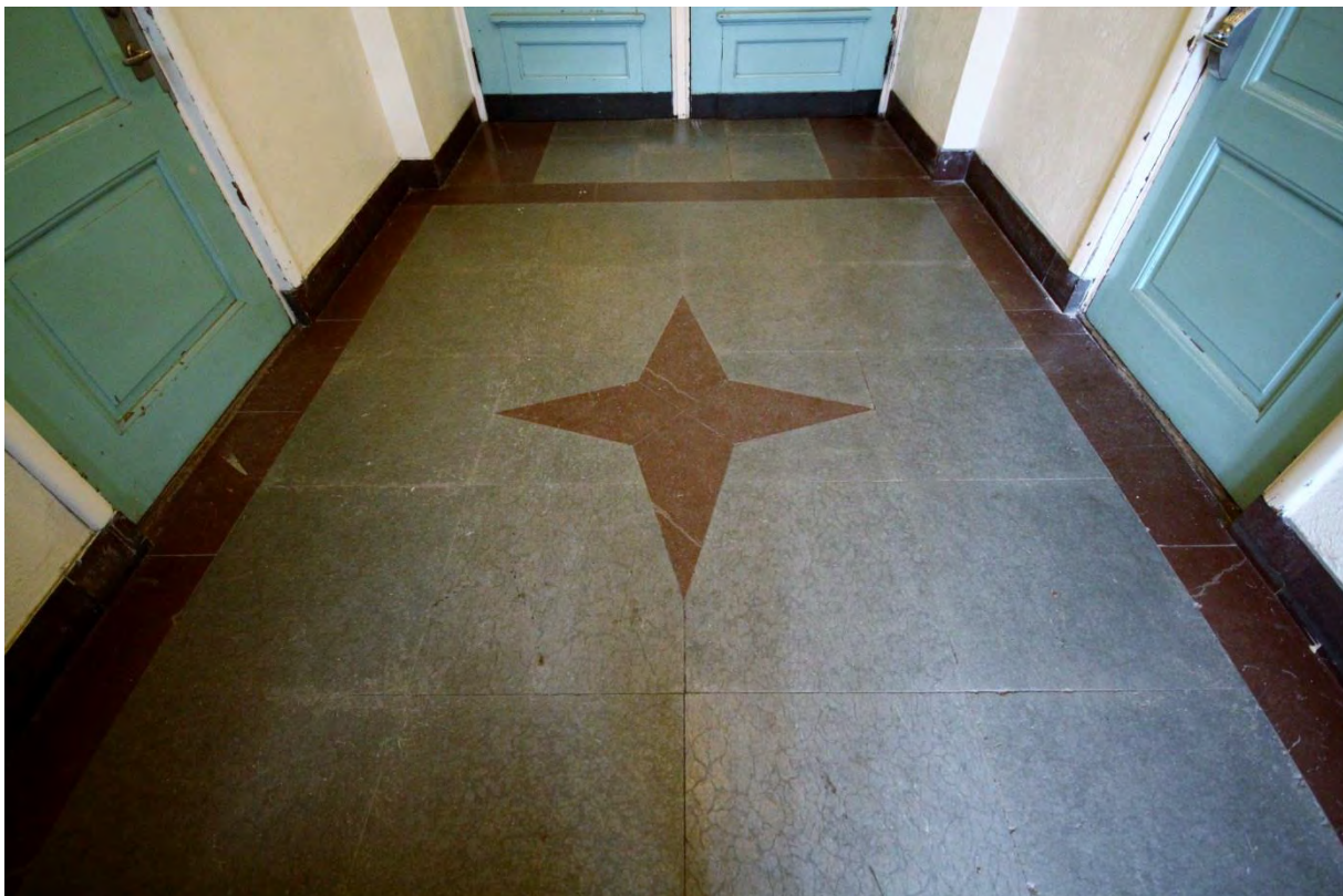
Rum 00.002. Rött och grått kalkstensgolv med intarsia i form av en fyruddig stjärna – original.
