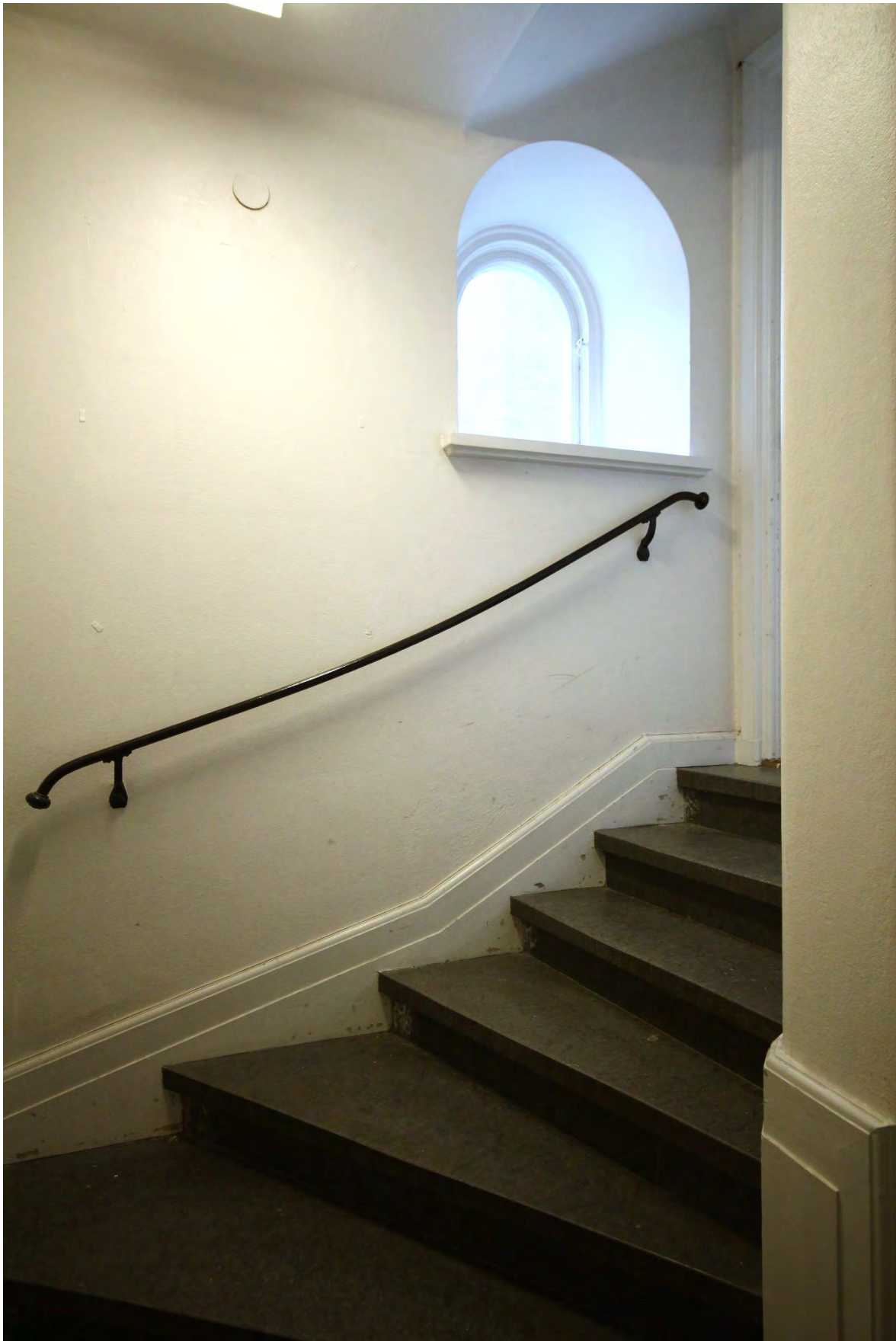
Välvt fönster mot gården i djup nisch med fönsterbänk. Kalkstentrappa, sockel och handledare lika ovan. Samtliga delar är original.
