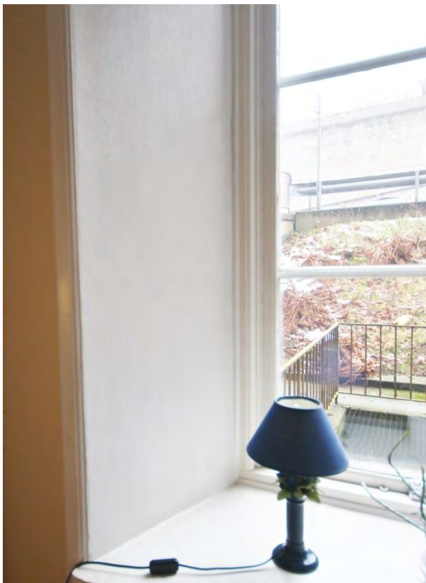
Rum 02.203a. Fönsterfoder och fönsterbänk – original. Dessa är bevarade i alla rum mot gården i rumsavsnittet.
