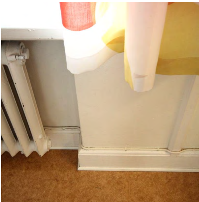
Rum 03.322. Sockel, foder, fönsterbänk, radiator – original.
