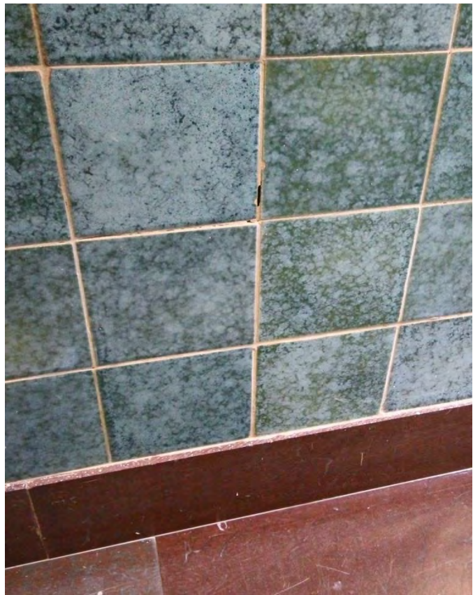
Kaklet i bröstningen har ett flammigt mönster i grönblå nyanser. Mönstret varierar från platta till platta och kaklet är sannolikt specialbeställt för byggnaden.
