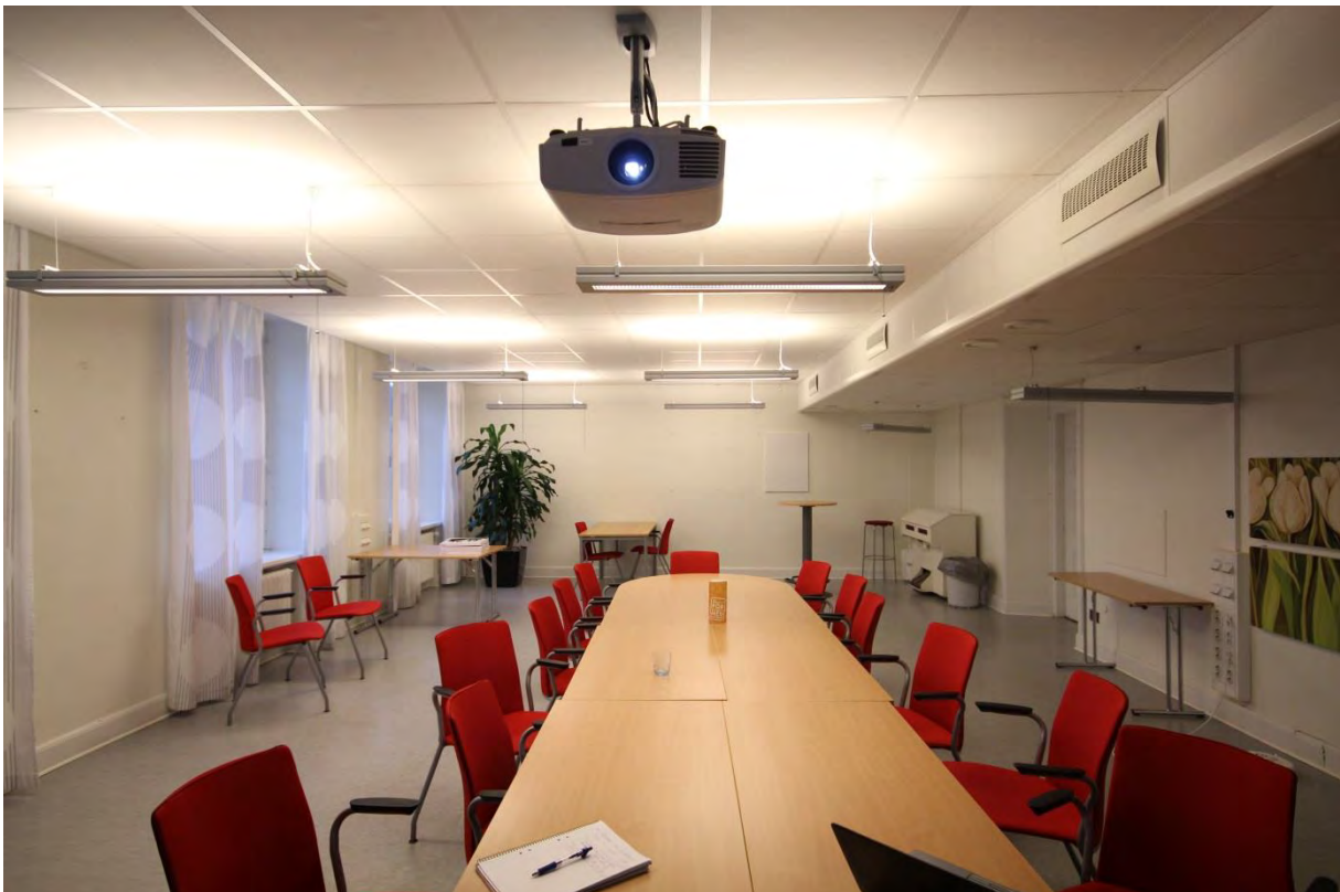
Rum 04.422. Två större sjuksalar som slagits samman till ett konferensrum. Socklar, foder, dörrar, fönsterbänkar och radiatorer är original.
