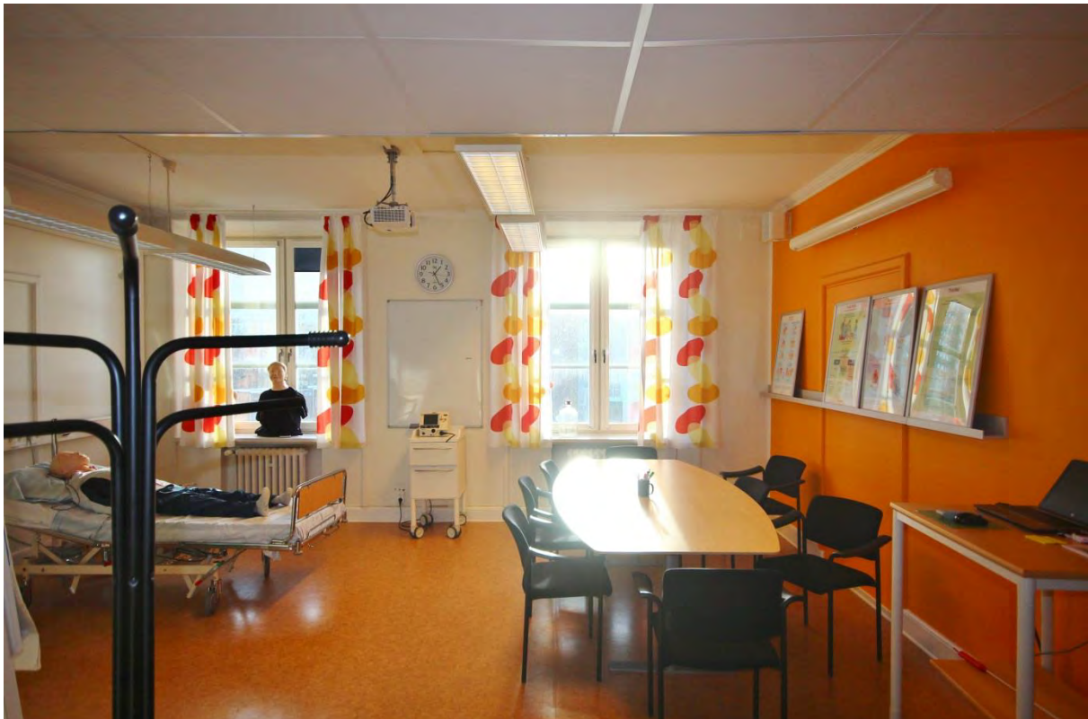
Rum 03.322. Rummet är sammanslaget av två mindre rum och har bevarade originaldetaljer som socklar, spegeldörrar och foder, fönsterbänk och taklist. Taket är putsat originaltak kompletterat med ventilationskanal i bakkant.
