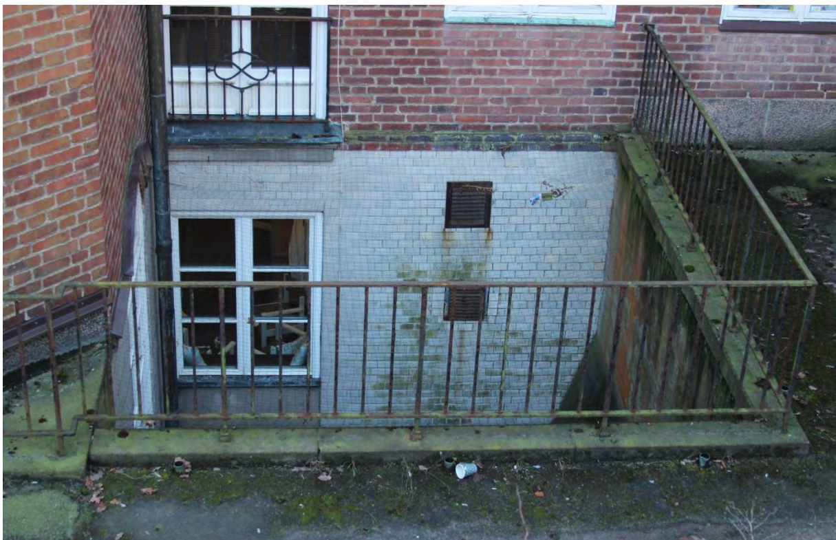
Ljuskårdar avsedda att sprida dagsljus till de nedre våningarna.
