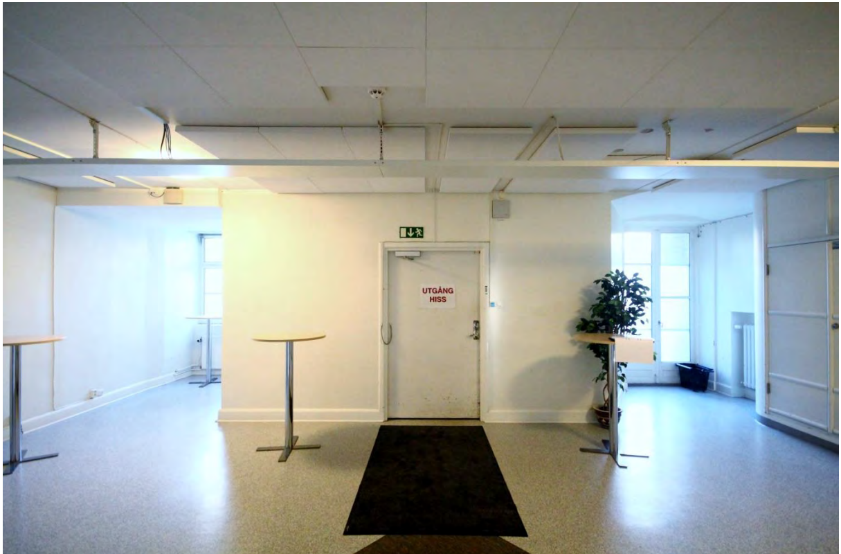
Vy mot trapphus och ursprunglig vägg flankerad av en fönsterdörr till vädringsbalkonger mot gården (norr).
