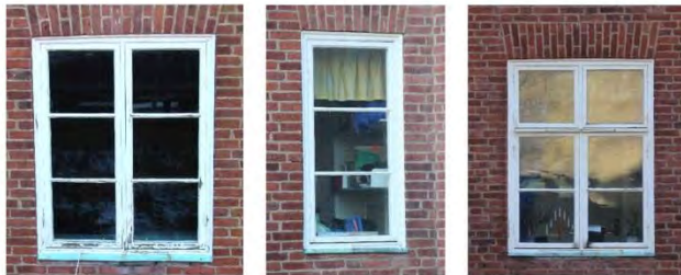
Exempel på originalfönster i olika utförande. Två- respektive enluftsfönster med liggande spröjs samt korspostfönster med liggande spröjs i nedre bågarna. Fönsterbleck i kopparplåt – original.
