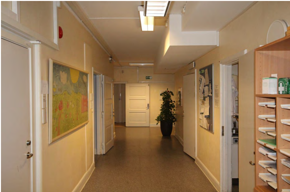
Rum 04.402. Korridoren har ursprunglig planlösning och bevarade originaldetaljer i form av socklar, foder, dörrar, taklist och putsat tak.
