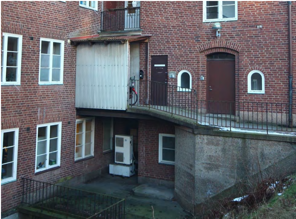
Till höger ursprunglig avsats med betongsockel i anslutning till originalentré. Avsatsen har en sekundär förlängning som vilar på en stålbalk och är i senare tid försett med väderskydd, bland annat för cyklar.
