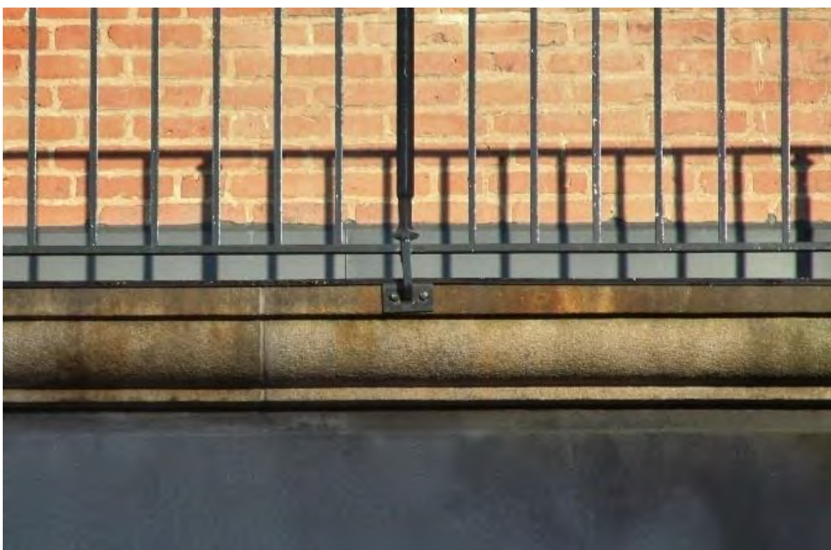
Granit avslutar även sockelvåningen uppåt, ovan denna skymtar fasad av handslaget rödbrunt Helsingborgstegel.
