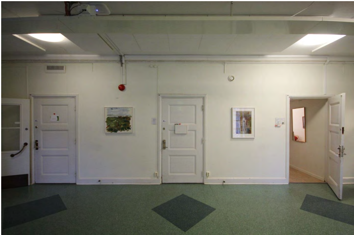
Originaldörrar i vägg mot söder.
