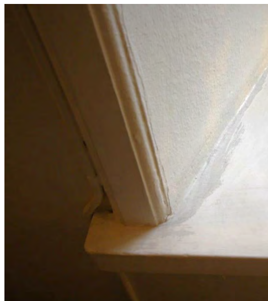
Rum 01.112. Fönsterbänk och foder – original.
