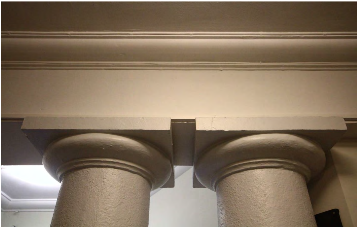
Tak och andra detaljer är slätputsade medan kolonnskäft och väggar har en grövre puts. Putsutförandet bedöms vara original.
