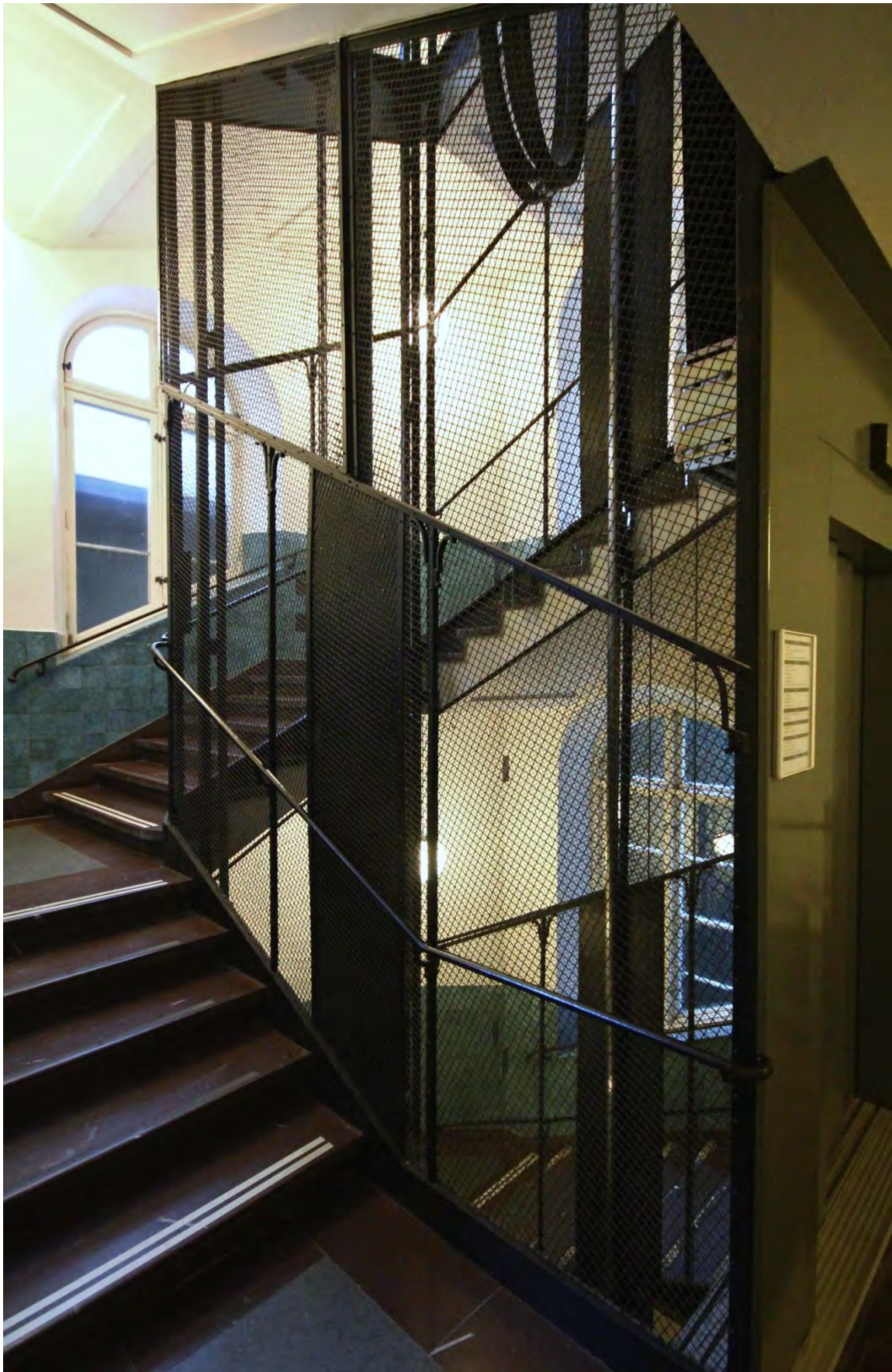
Huvudtrapphuset, plan 1-2. Trapphuset har fönster åt tre håll och ett öppet hisschakt. Samtliga delar i bild, utom hissfronten, är original.
