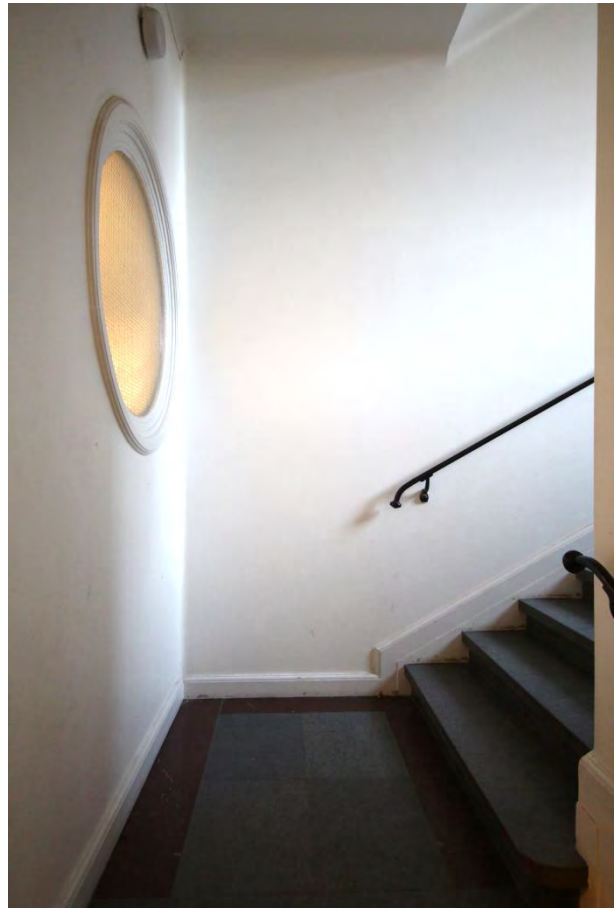
Runt fönster mot korridoren på plan 3. Fönstret var sannolikt spröjsat i originalutförande, men har senare försetts med trådglas.
