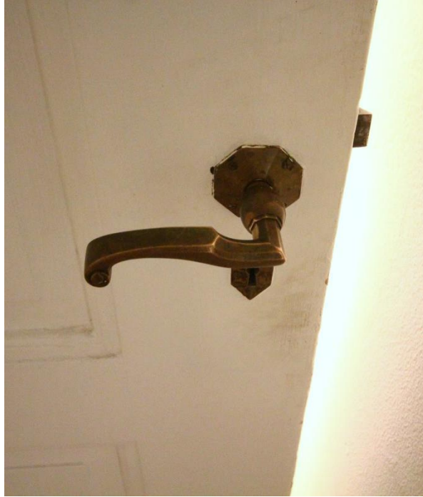
Spegeldörr mot rum 01.132a. Detalj – mässingstrycket är original.
