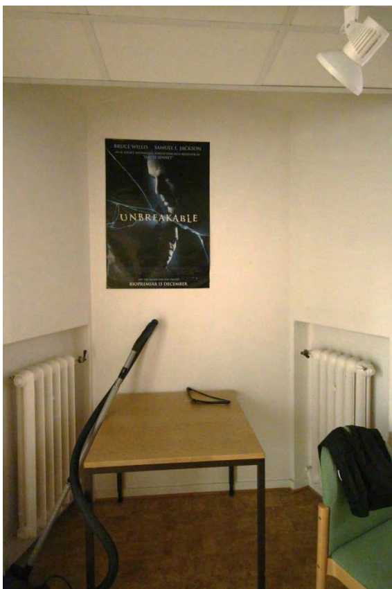
Rum 02.205. Igensatt dörröppning mot en ursprunglig vädringsbalkong. Kvarvarande originalradiatorer.
