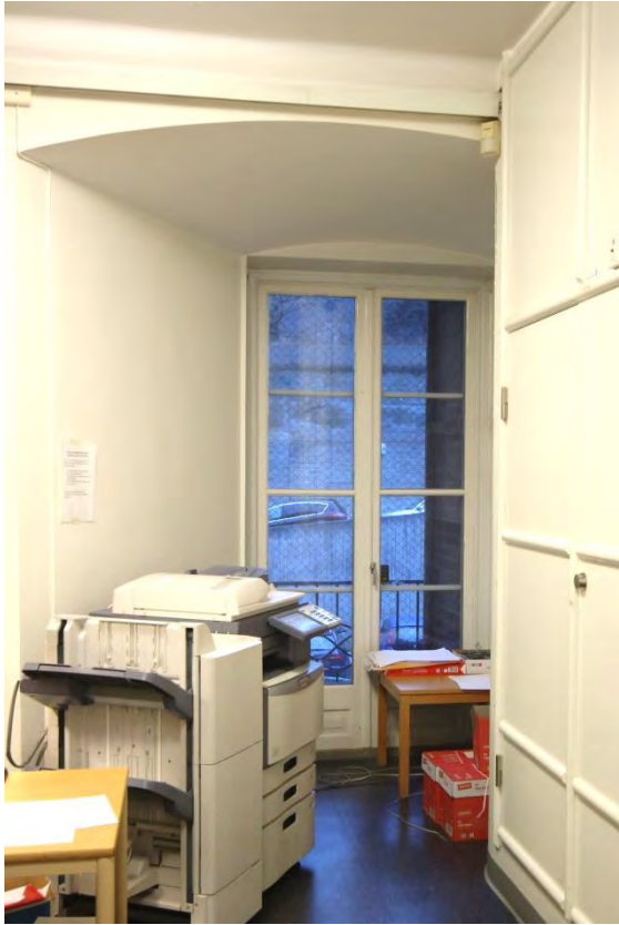
Inåtgående kopplad fönsterdörr i trä med liggande spröjs – original.
