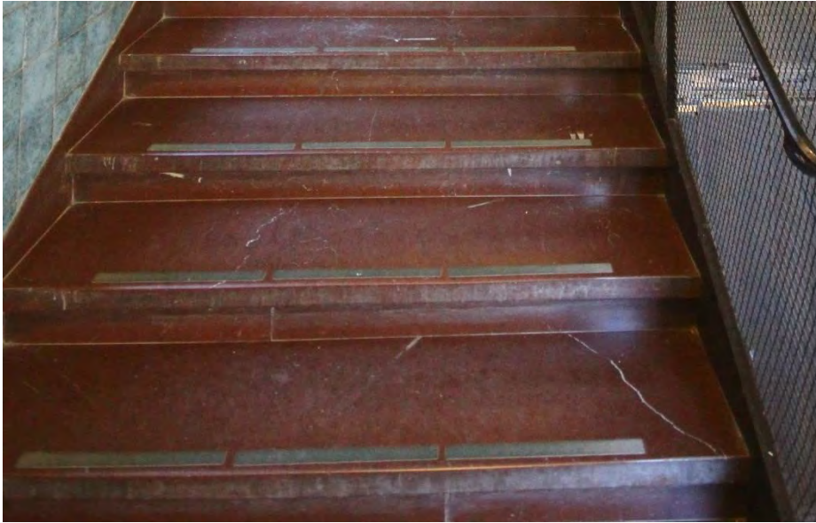
Trapplopp i röd kalksten med inslag av strimmor.
