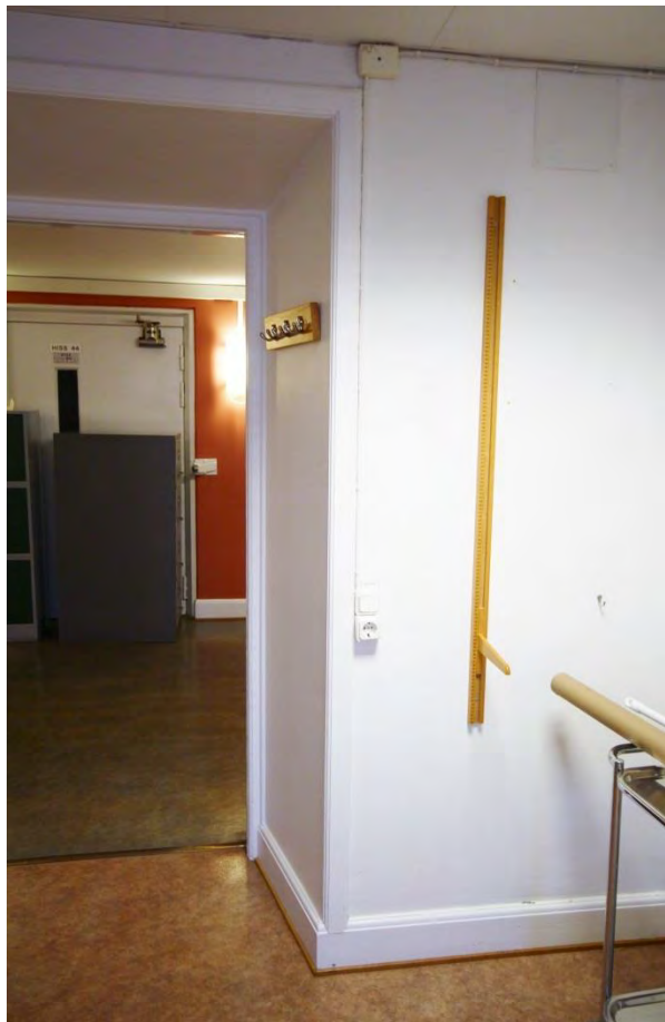
Rum 02.228 utgör ett undantag i rumsavsnittet och har även bevarade socklar, foder och dörr.
