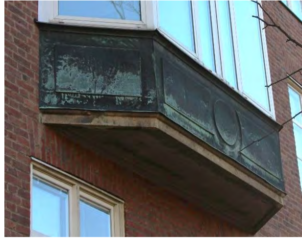
Burspråk mot väster med ornamenterad kopparplåt och underkant i dekorativt bearbetad betong – original.
