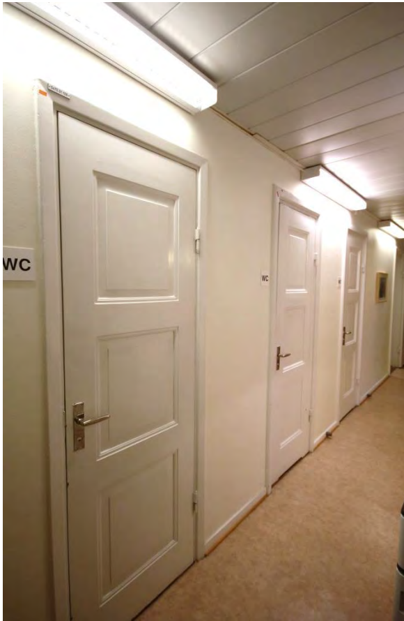
Rum 01.102. Spegeldörrar mot wc – original och äldre kompletteringar.
